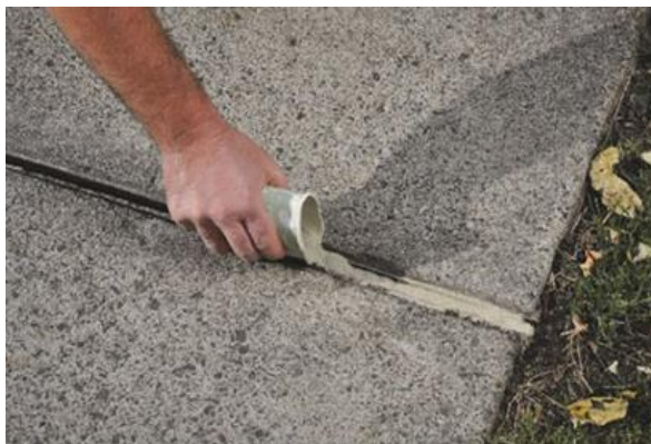
Slika 36: Popunjavanje pukotina FRP-om [3]
