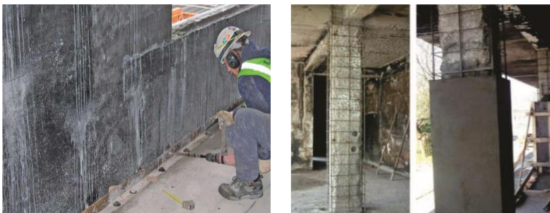
Slika 34 i 35: QuakeWrp FRP Retrofit sustav [35]
