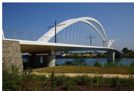
Slika 40: Buehl-Balzhofen Bridge, Njemačka [38]
