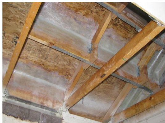
Slika 37: Primjena FRP-a na drvenoj krovnoj konstrukciji [36]
