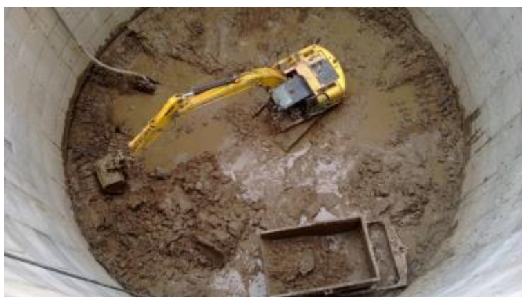
Slika 5: Podizanje vode prilikom iskopa [10]
