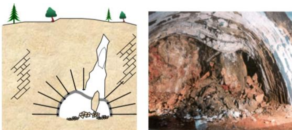
Slika 16: Ispadanje bloka iz kaverne u kaloti tunela Sv.Rok [15]
