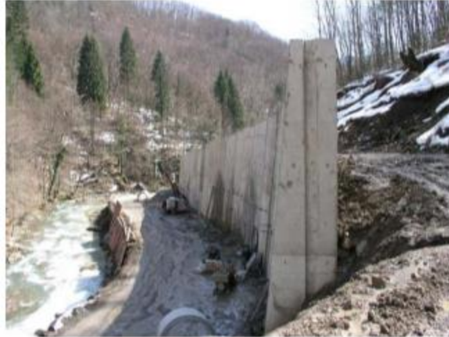
Slika 7 : Gravitacijski potporni zid [17]
