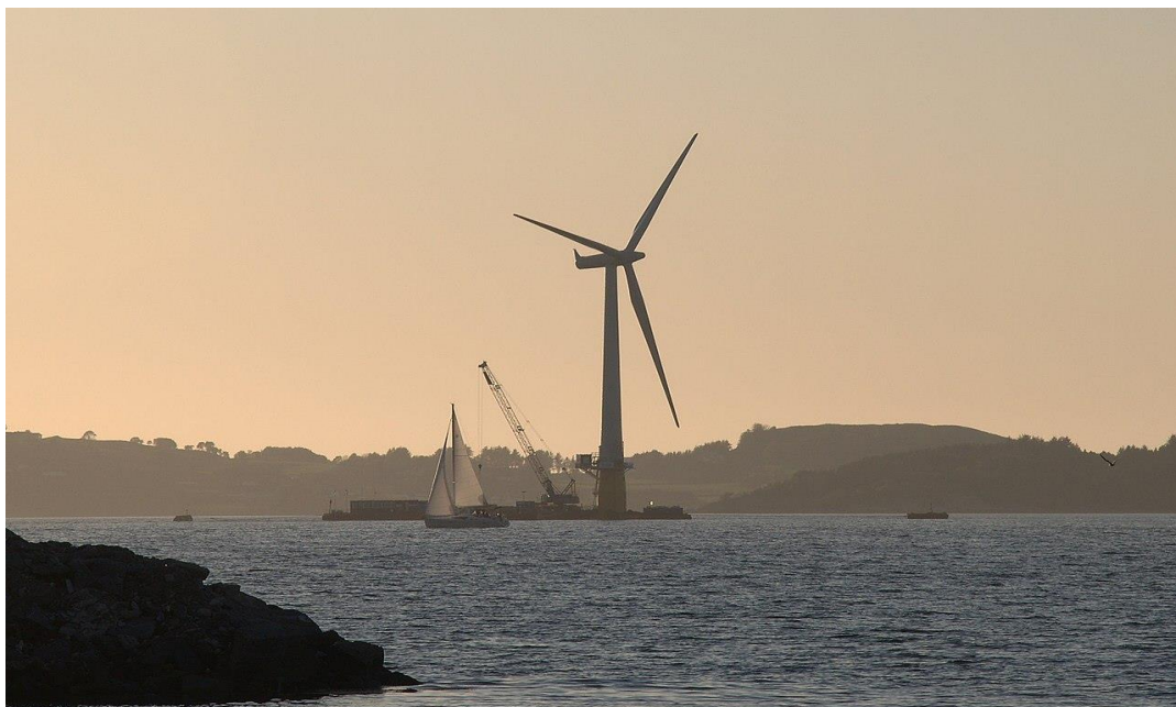
Slika 37. Prvi plutajući vjetroagregat, koji je sklopljen Stavangeru (Norveškoj), prije nego je postavljen u Sjevernom moru
