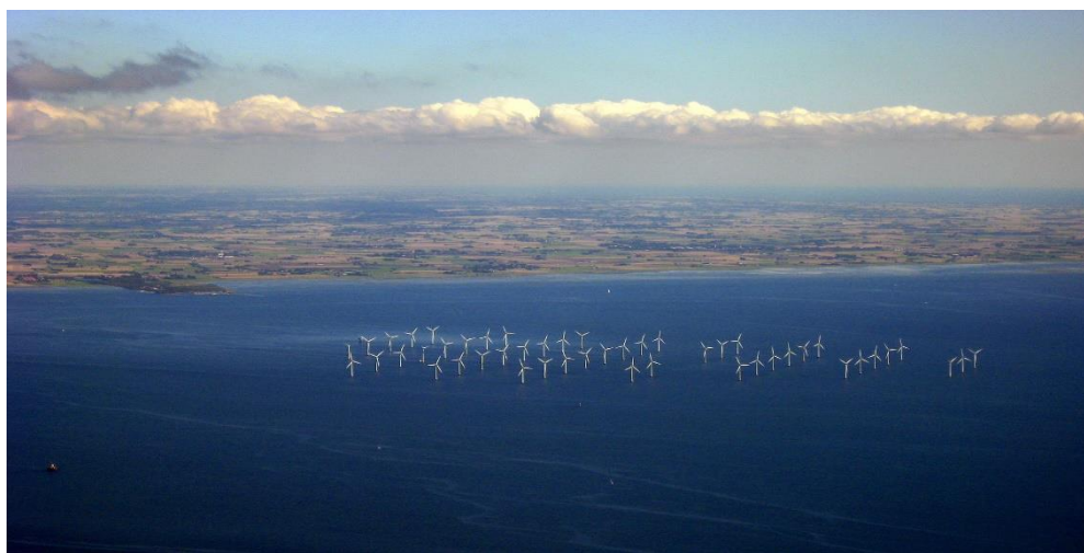
Slika 35. Priobalna vjetroelektrana Lillgrund (Švedska)
