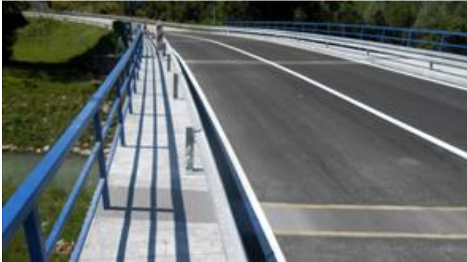
Slika 5: Bitumenska reška urezana u trošeni sloj asfalta [3]
