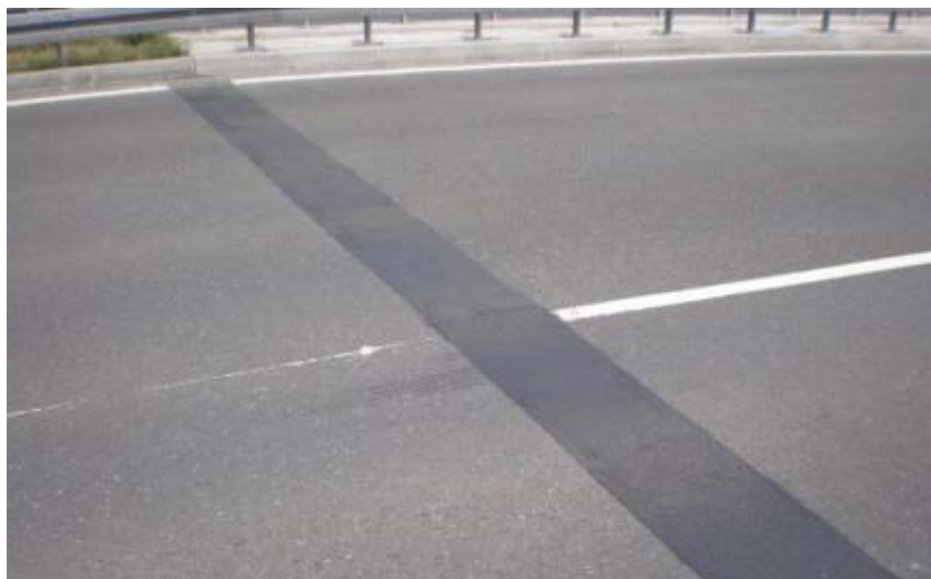
Slika 7: Prijelazna naprava „thorma joint“ [5]
