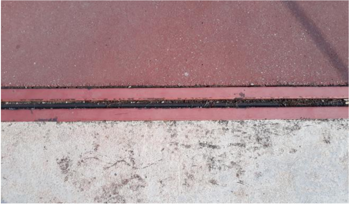
Slika 40: Prijelazna naprava na mostu
