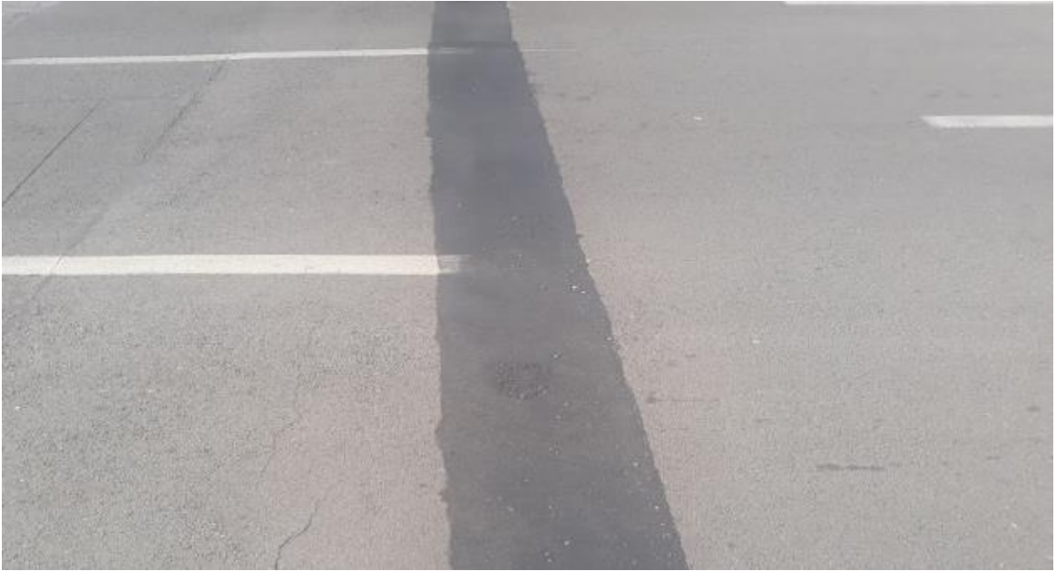
Slika 50: Prijelazna naprava na mostu
