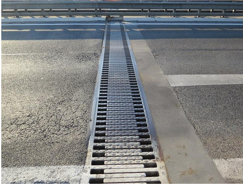
Slika 15: Češljasta (prstasta) prijelazna naprava [11]
