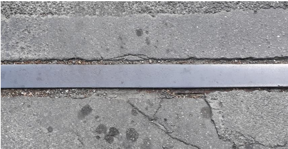
Slika 24: Prijelazna naprava na mostu Trnovica
