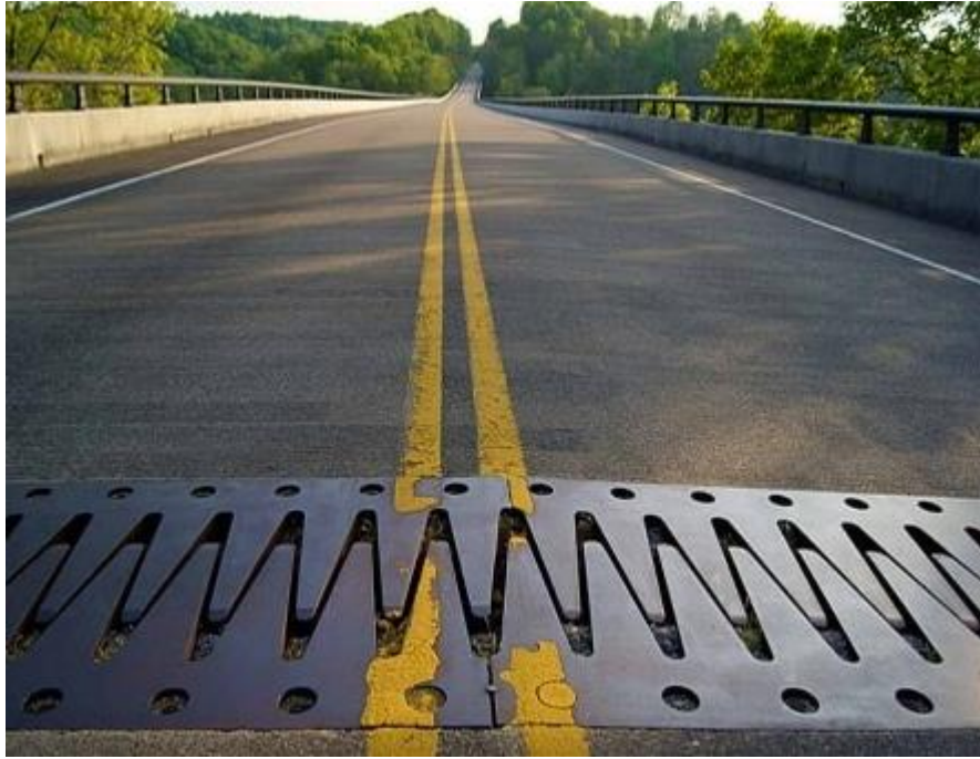
Slika 17: Češljasta (prstasta) prijelazna naprava [13]
