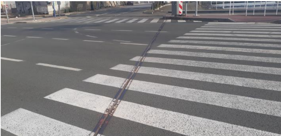
Slika 41: Prijelazna naprava na mostu
