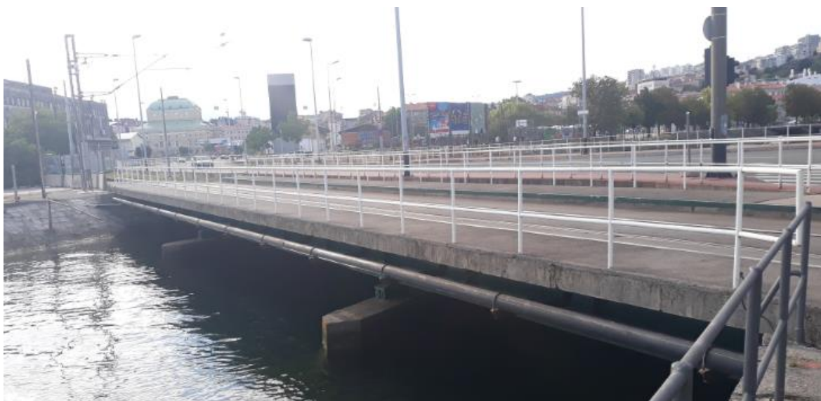
Slika 43: Pogled na most
