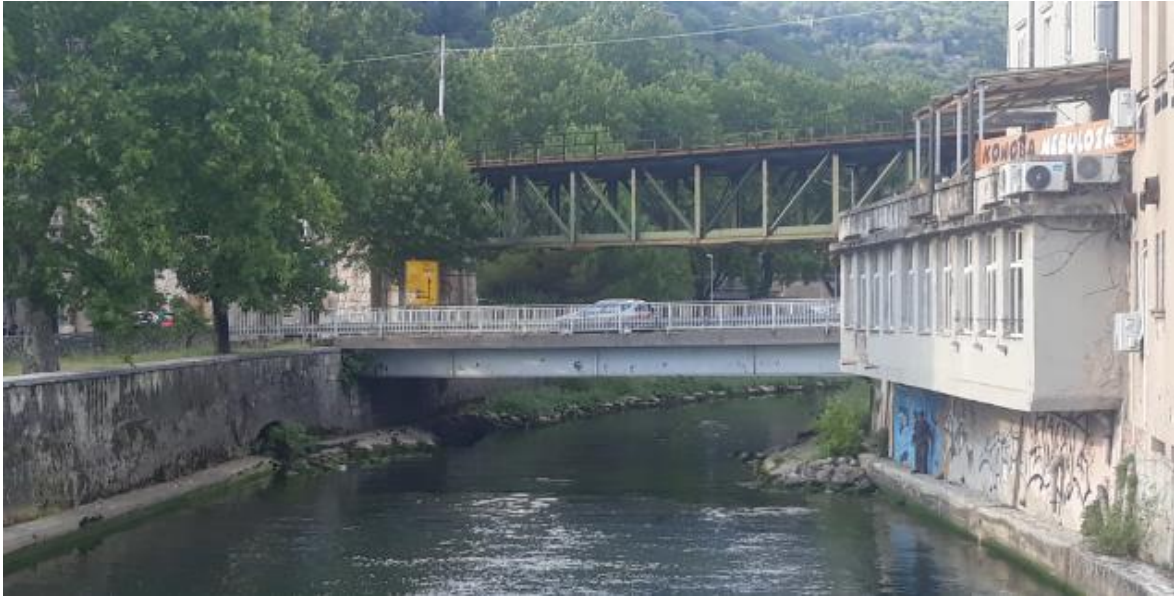
Slika 25: Pogled na most u ulici Školjić
