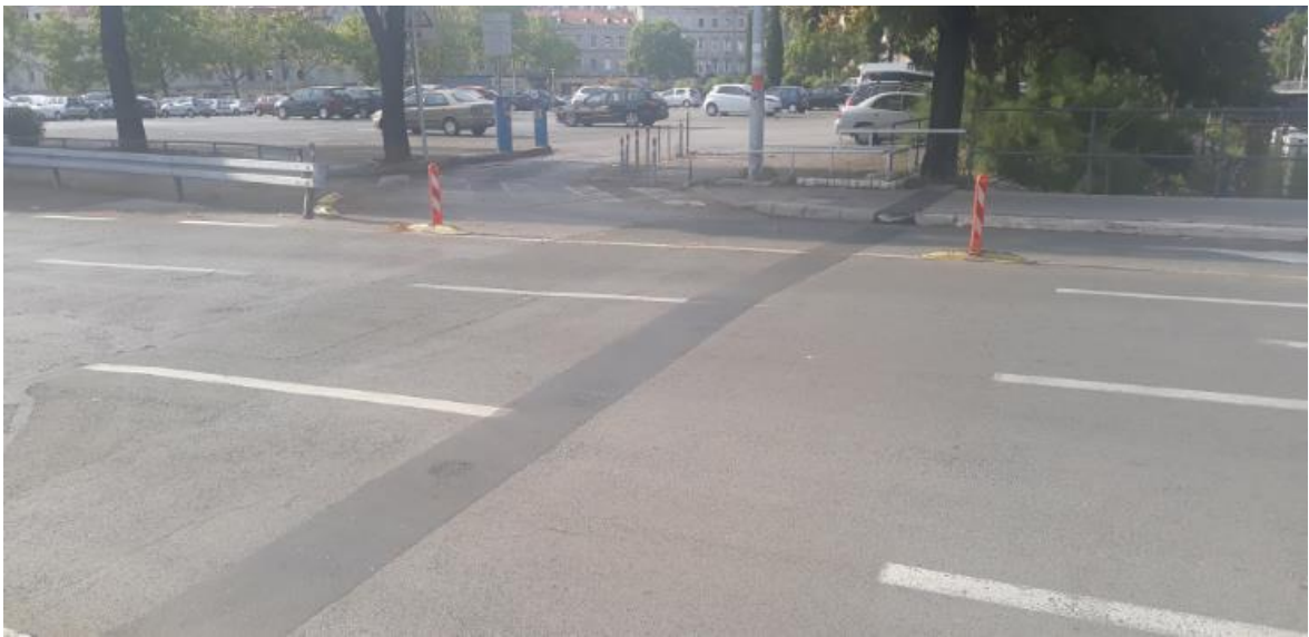
Slika 49: Prijelazna naprava na mostu
