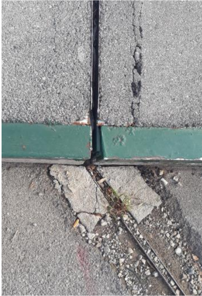
Slika 44: Prijelazna naprava na mostu
