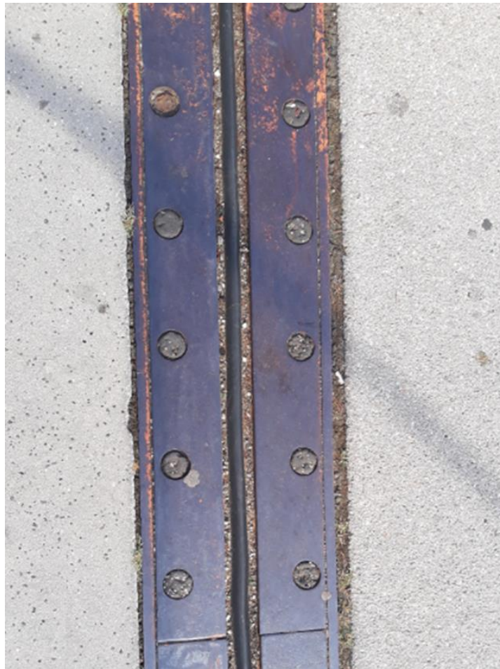
Slika 51: Prijelazna naprava na mostu
