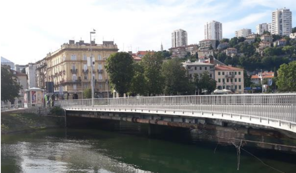
Slika 34: Pogled na most sa strane
