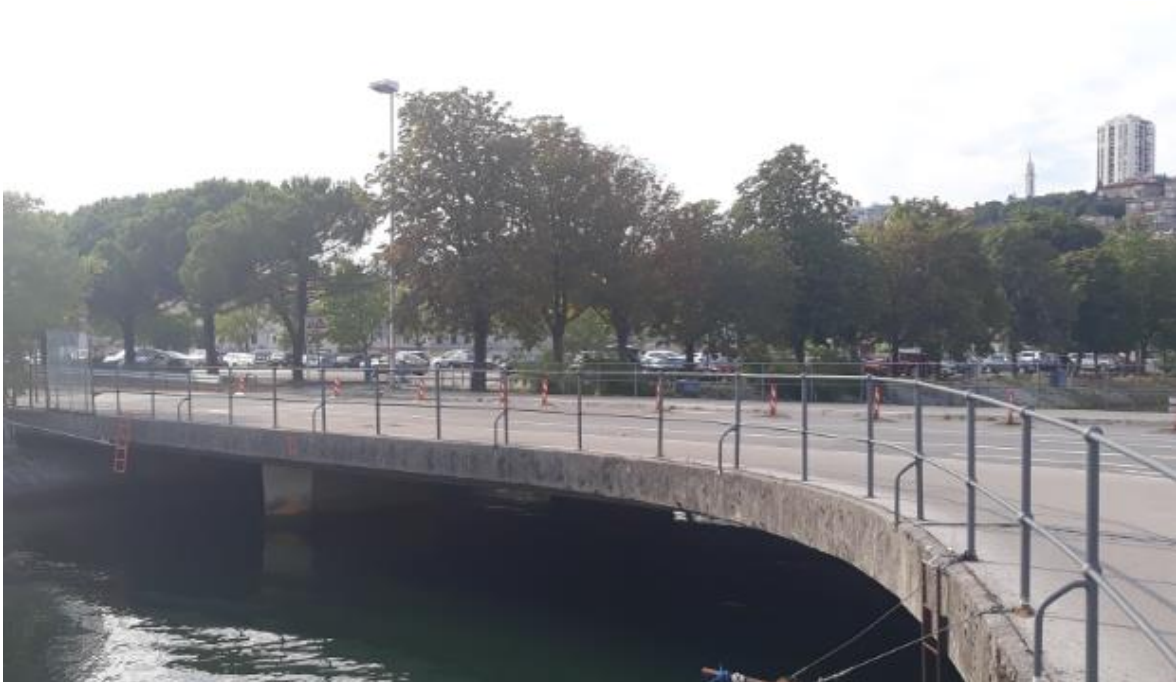
Slika 47: Pogled na most
