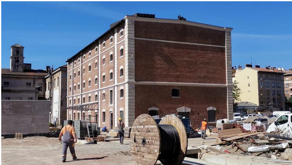
Slika 21: Rekonstrukcija Ciglene zgrade i njena prenamjena u Dječju kuću [slika autora]
