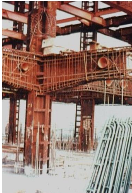
Slika 3: Okvir od konstrukcijskog čelika i armiranog betona [2]
