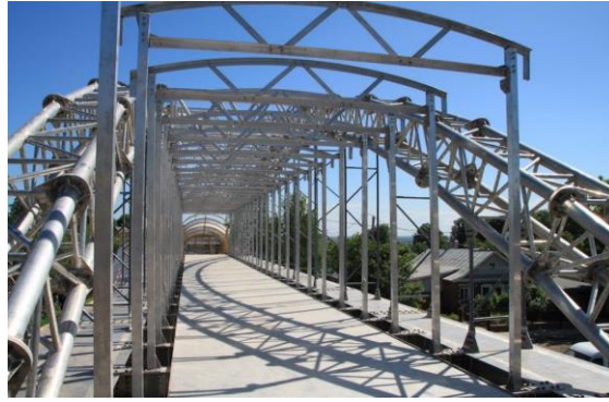
Slika 3: Most od lagane aluminijske legure u Rusiji [6]
