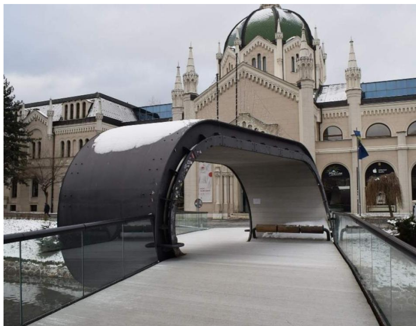
Slika 27: Pogled na zakrivljeni dio mosta Festina lente [20]
