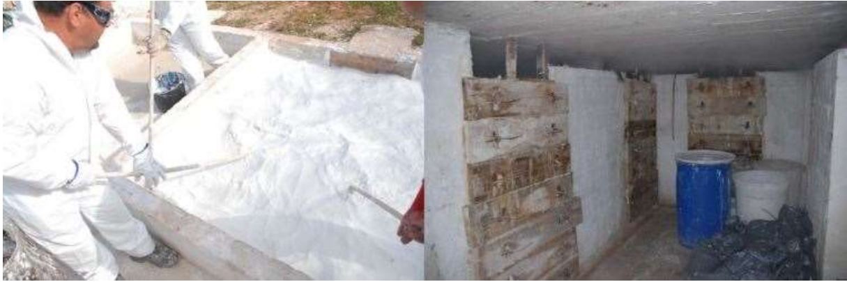
Slika 21 - Gašenje živog vapna u vodi prije ispuštanja u jame (Kapitel d.o.o.)
