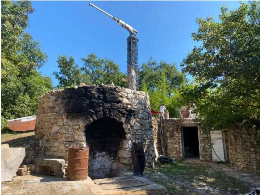
Slika 6 – Vapnenica (japnenica) za tradicijsku proizvodnju vapna Kapitel d.o.o., Istra
