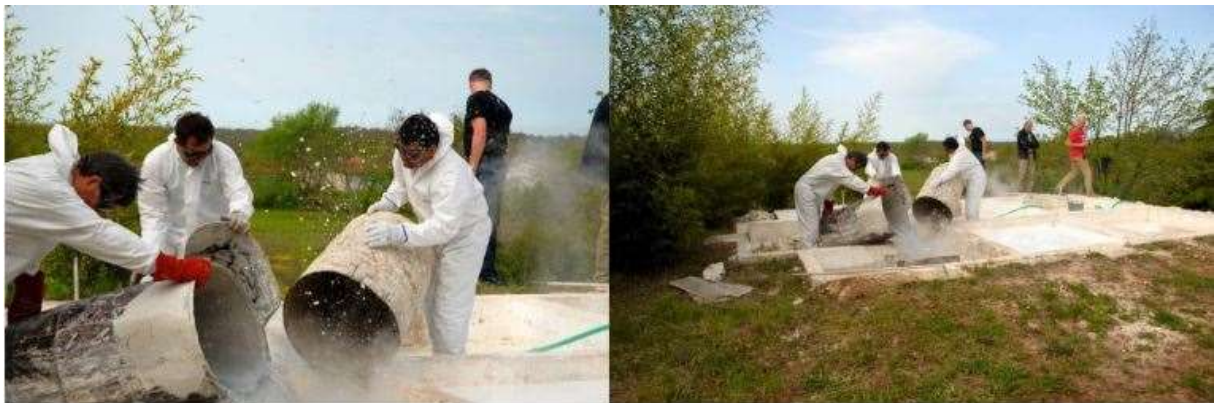
Slika 20 – Ulijevanje vode na živo vapno (Kapitel d.o.o.)
