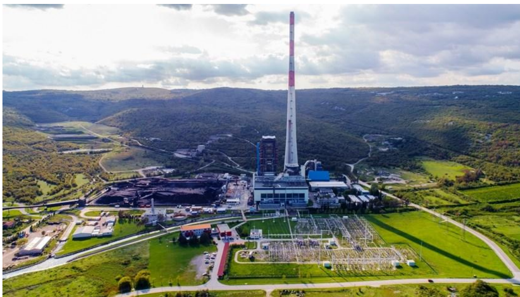
Slika 6. Postrojenje termoelektrane na ugljen, Plomin
