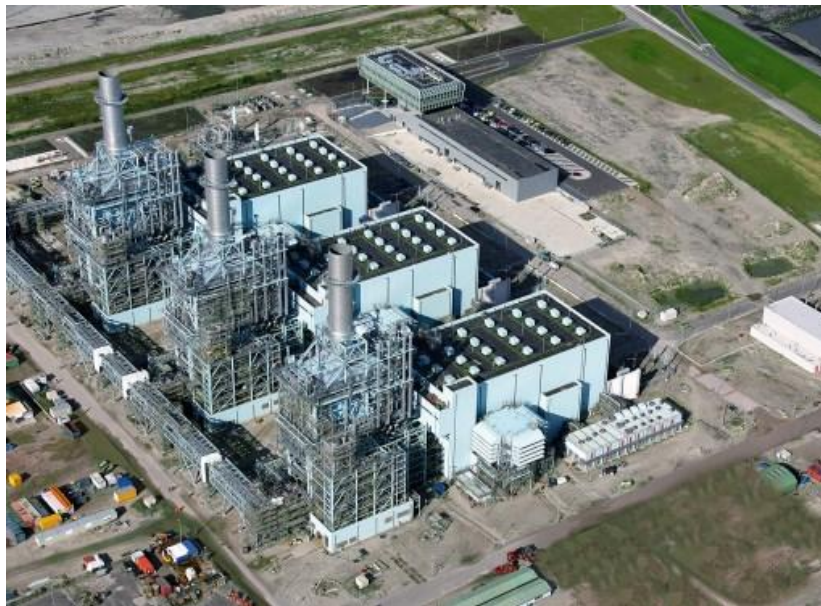
Slika 8. Pogon termoelektrane na plin
