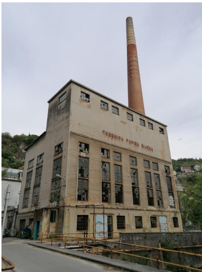
Slika 62. Zapadno pročelje zgrade
