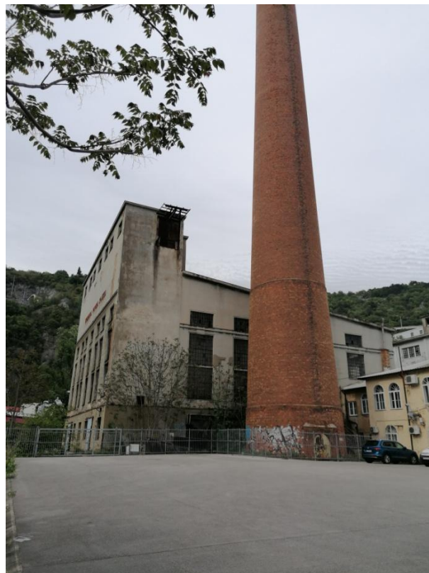
Slika 64. Južno pročelje zgrade
