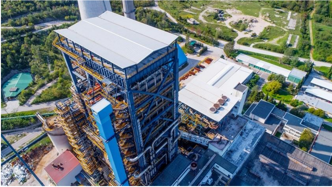
Slika 7. Zgrada termoelektrane na ugljen za proizvodnju i distribuciju energije, Plomin
