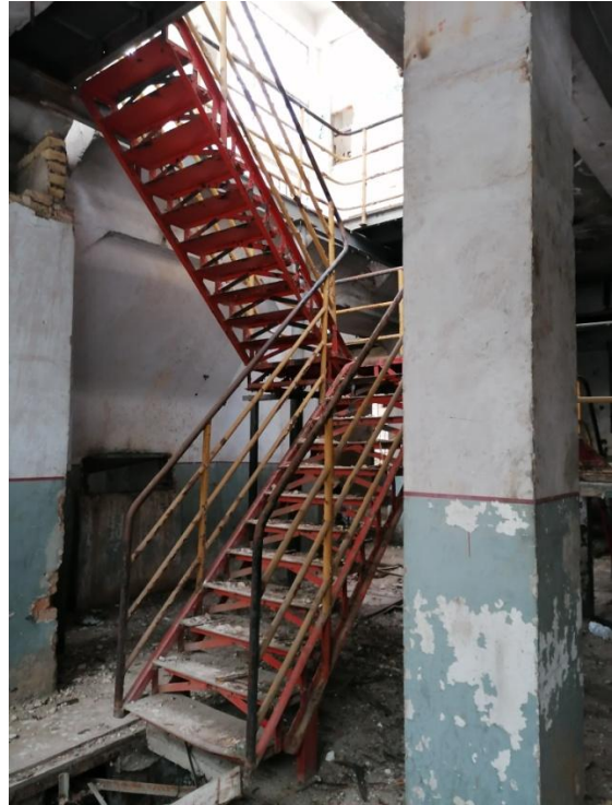
Slika 67. Čelična stubišta koja povezuju prizemlje sa prvim katom
