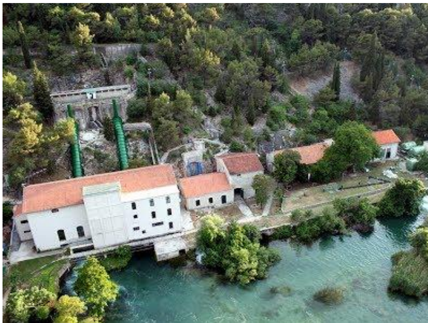
Slika 10. Hidroelektrana Jaruga na rijeci Krki
