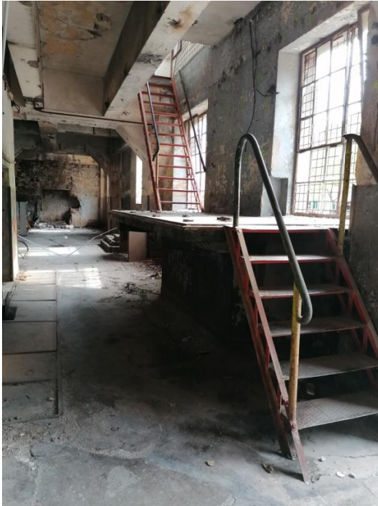
Slika 67. Čelična stubišta koja povezuju prizemlje sa prvim katom
