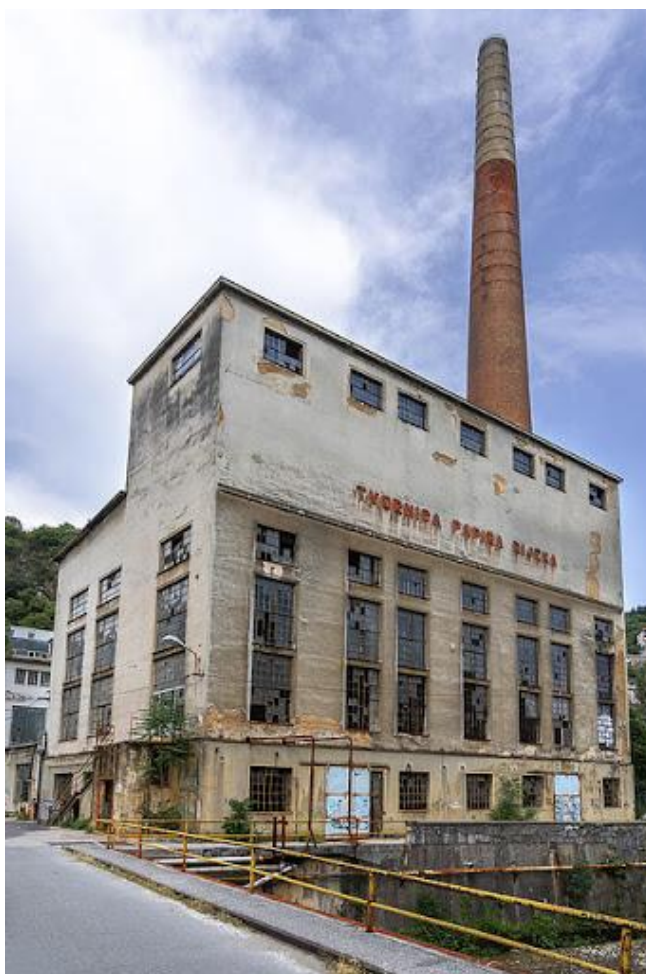
Slika 53. Energana tvornice papira
