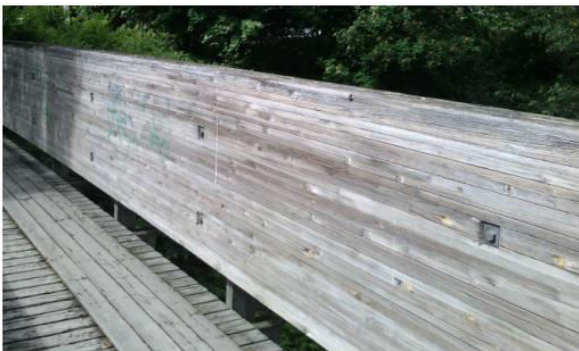
Slika 21: Zaštita glavnog nosača oblogama (desna slika) [5]
