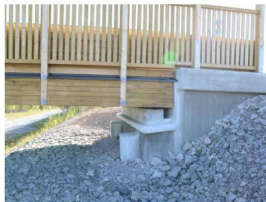
Slika 17: Ventilacija i odvojenost ležaja od tla (desna slika) – prozračnost i čistoća ležajnog dijela konstrukcije[5]
