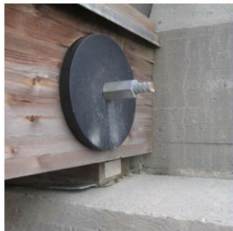
Slika 18: Uvučenost ležaja ispod nosača (desna slika) – zaštita od zadržavanja vode[5]
