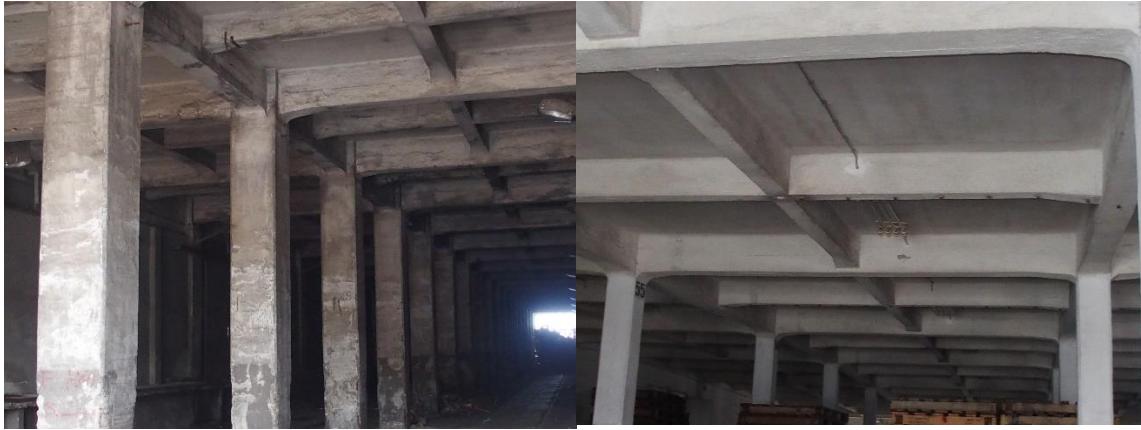
Slika 5: Prikaz stupova u zgradi
