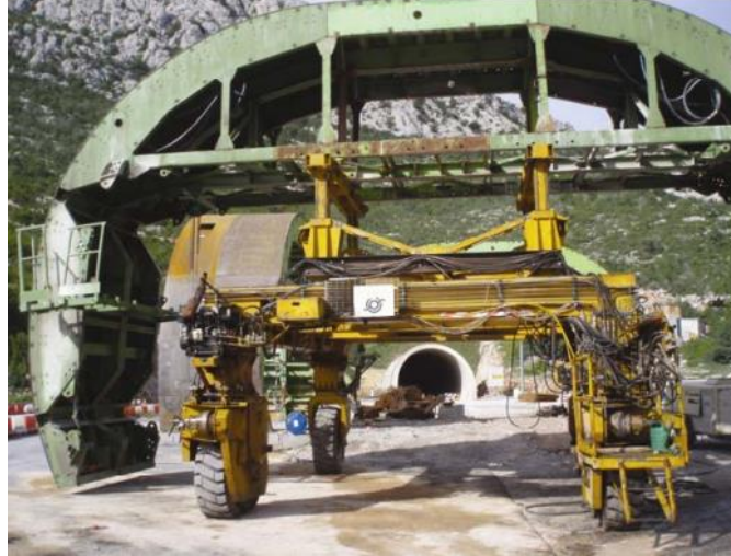
Slika 17. Samohodna hidraulična oplata pred južnim portalom tunela Sv. Rok [29]
