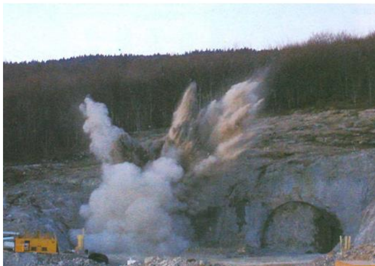
Slika 15. Prva miniranja na sjevernom ulazu u tunel [29]
