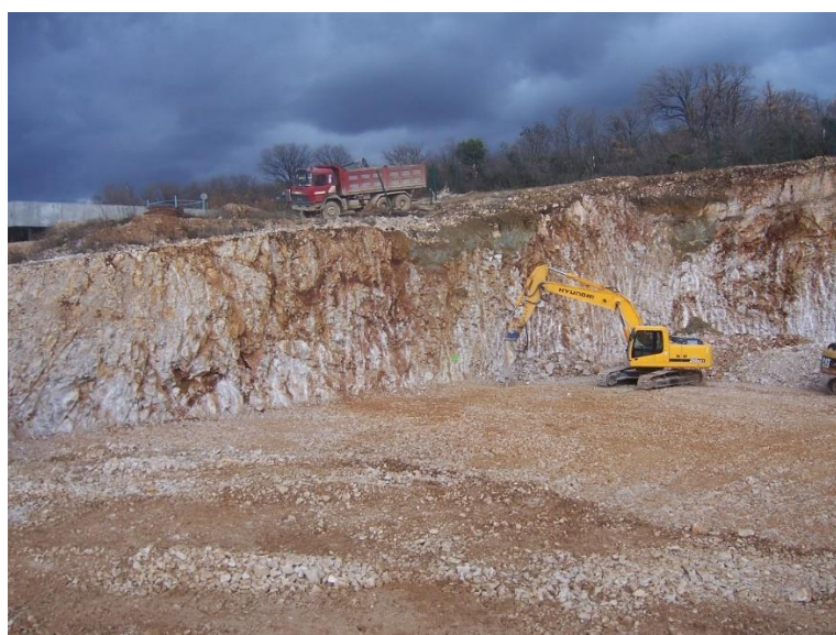
Slika 34: Građevna jama - pokos zapad [32]
