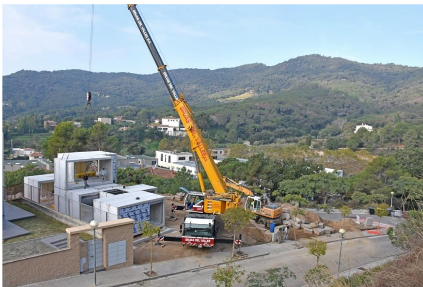
Slika 57: Postavljanje prstenastih ćelija na gradilištu [1]
