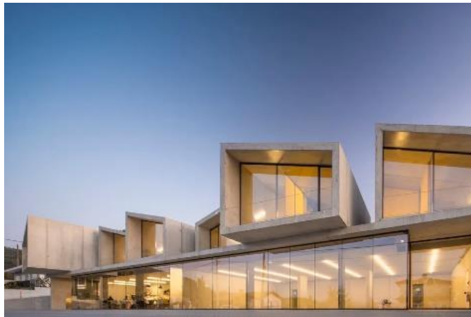
Slika 9: Betonske prstenaste ćelije [6]
