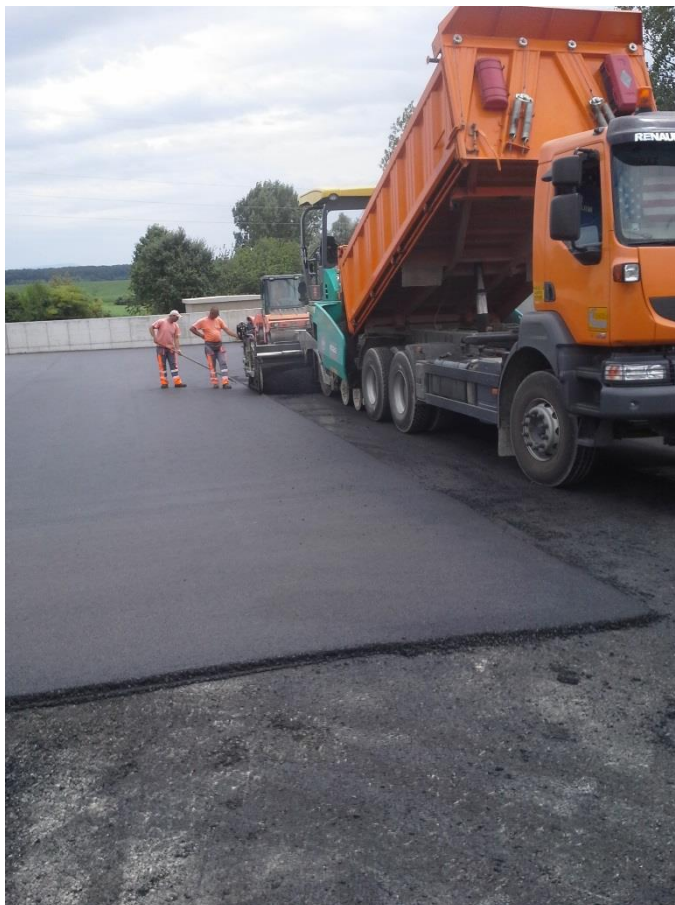
Slika 11: Ugradnja asfalta finišerom
