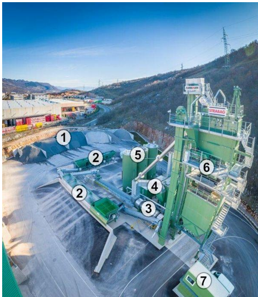
Slika 10: Ciklička asfaltna baza tvrtke Strabag d.o.o. [18]
