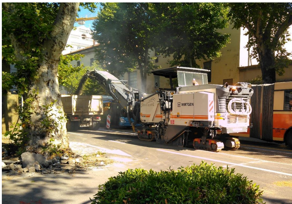
Slika 12: Glodalica za asfalt u radu
