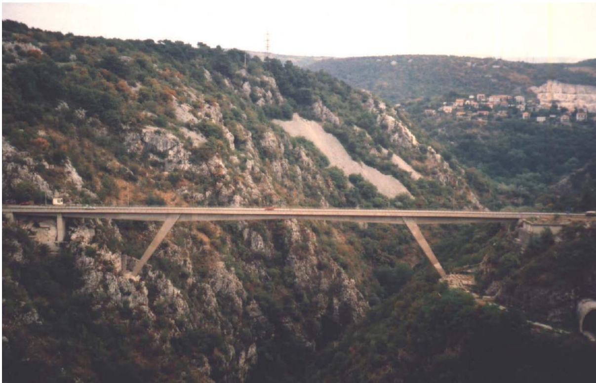
Slika 8. Pogled na most Rječina iz zraka [8]
