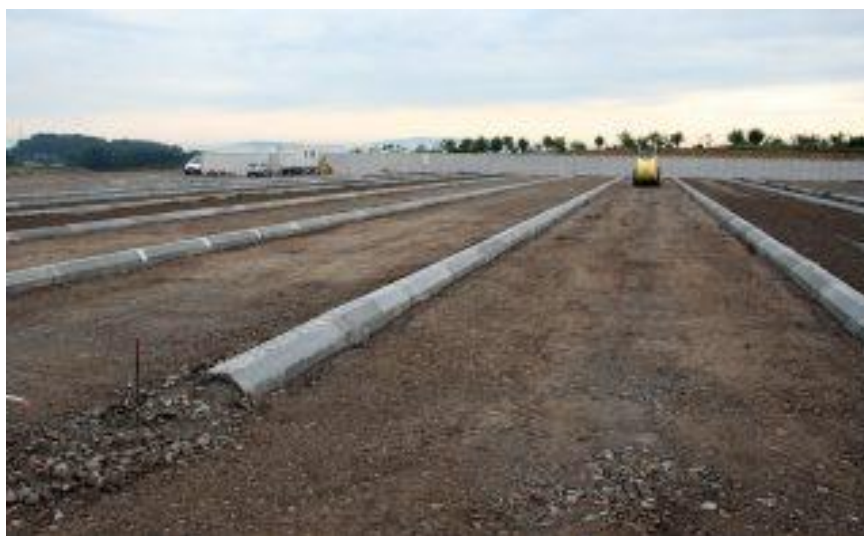
Slika 28. Postavljanje betonskih aeracijskih kanala za kompostne hrpe(izvor: https://www.compost-systems.com/en/produkte/belueftungstechnik#belueftungstechnik-rohre datum pristup: 5.6.2021)
