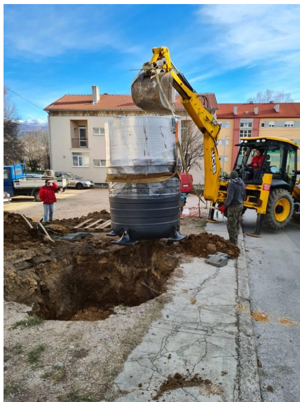
Slika 11. Postavljanje polupodzemnog spremnika u Kninu ( izvor: snimio autor 2020. godina)
