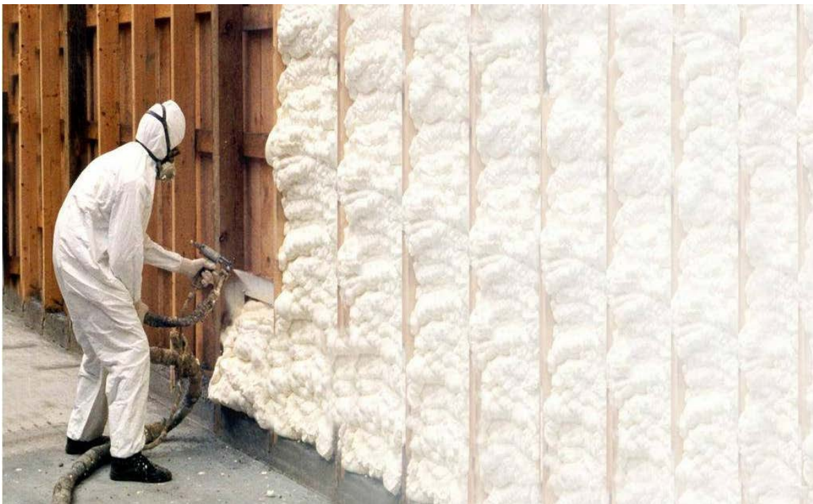
Slika 2.15 Instalacija poliuretanske (PUR) pjene
