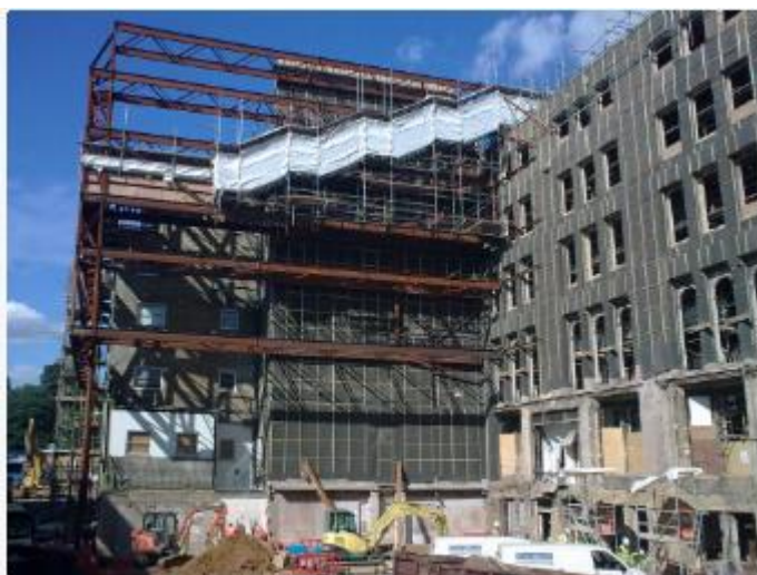
Slika 23: Privremena konstrukcija za pridržavanje fasade [8]
