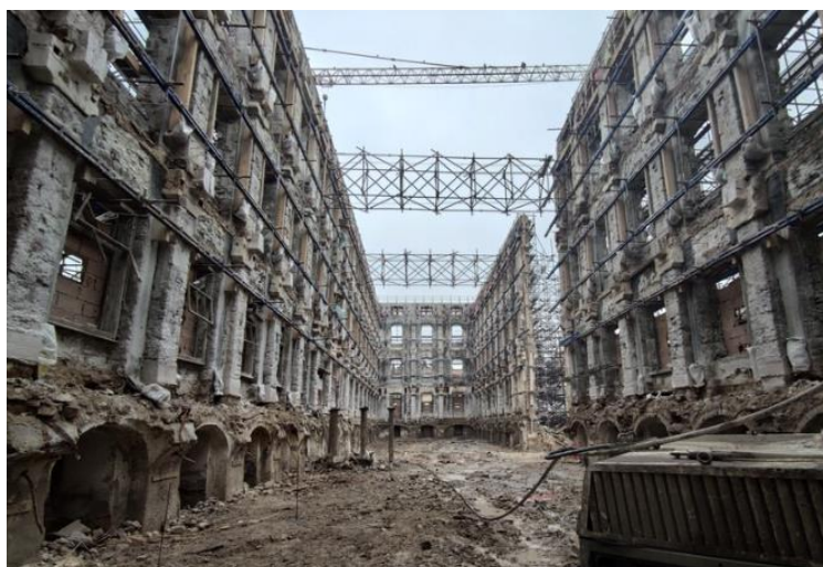
Slika 30: Unutarnja skela za pridržavanje fasade [12]
