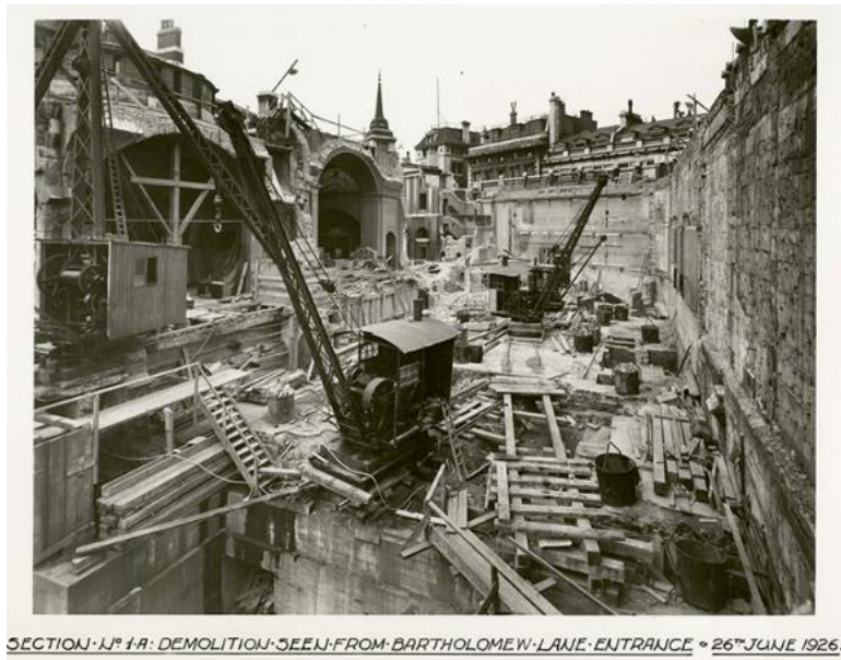
Slika 1: Korištena mehanizacija i radovi na rekonstrukciji Engleske banke tijekom 1926. godine [3]
