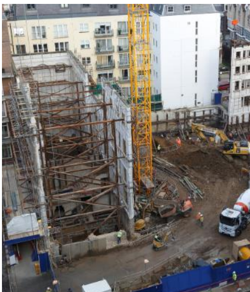
Slika 20: Unutarnja konstrukcija za pridržavanje fasade [8]
