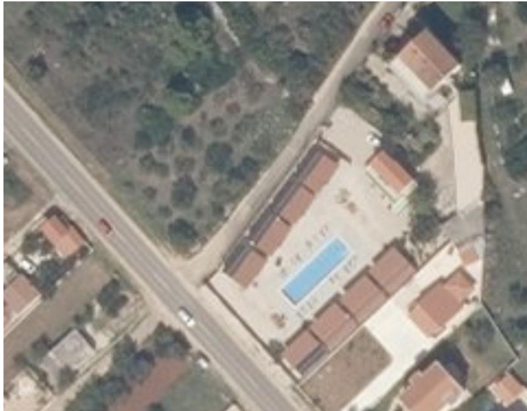
Slika 19. Urbanistička devastacija prostora unutar zaštitnog koridora ceste[13]
