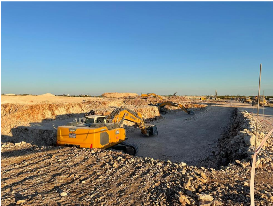
Slika 31. Zona 8 u izgradnji (izvor: snimio autor 03.08.2021)
