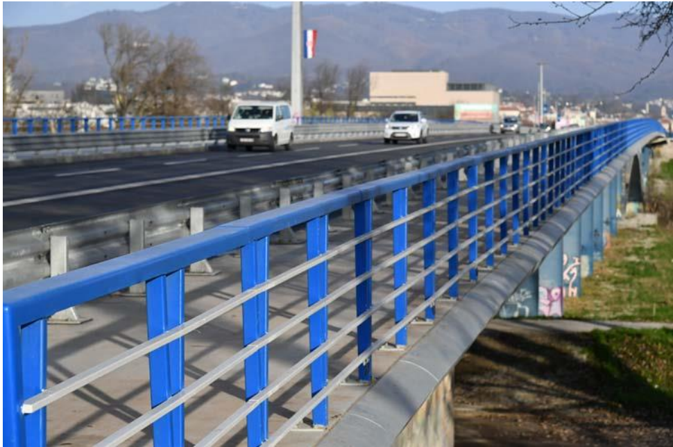
Slika 7: Most slobode nakon sanacije [21]
