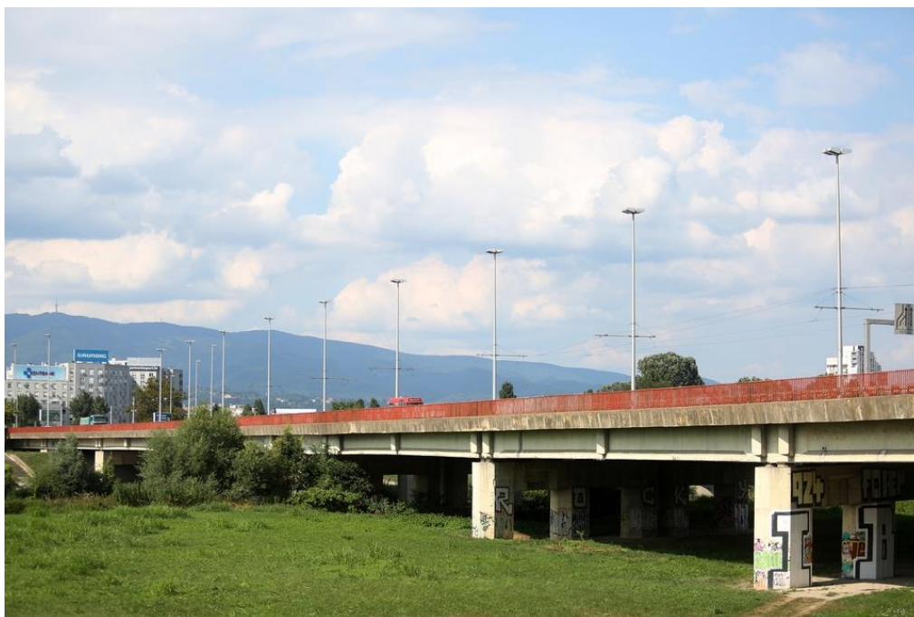
Slika 11: Pogled na Jadranski most s desne obale Save [30]
