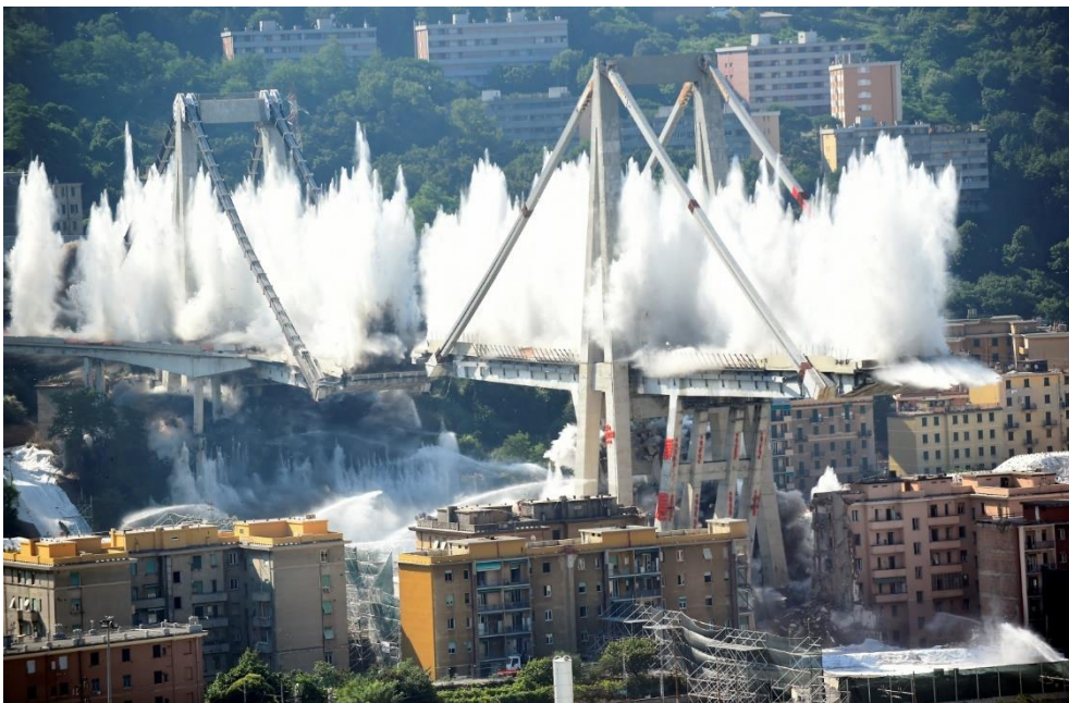
Slika 8. Rušenje ostatka Morandijevog mosta
