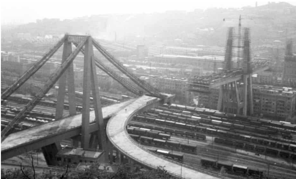
Slika 5. Morandijev most za vrijeme izgradnje
