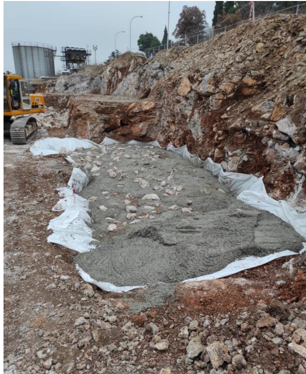
Slika 15. Izrada podložnog betona sa max. 30% kamenih blokova
