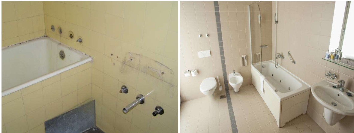
Slika 58: Sanitarije soba hotela Jadran prije (lijevo) i nakon rekonstrukcije (desno)
