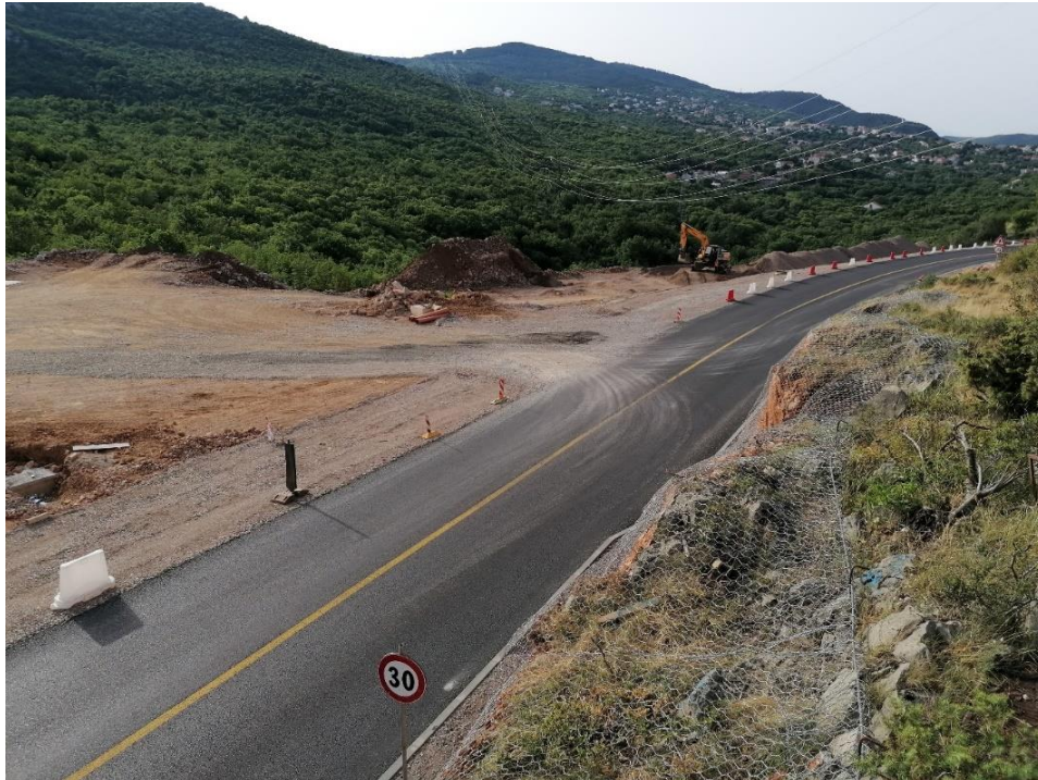
Slika 18: Trenutno stanje radova na gradilištu na dan 13.7.(fotografija autora)
