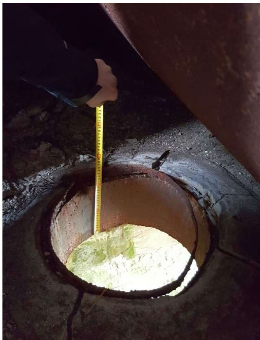
Slika 1: Mjerenje debljina međukatnih konstrukcija
