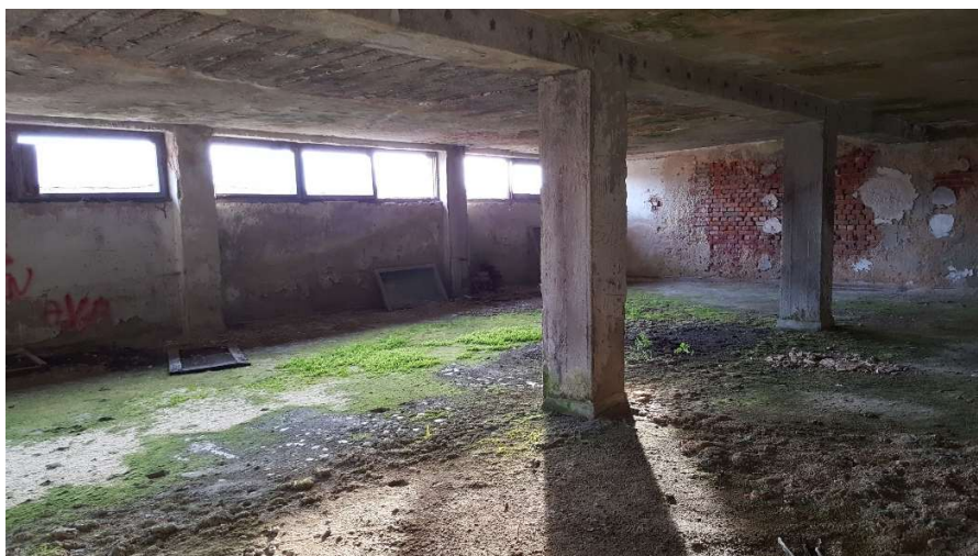
Slika 40: Konstrukcije betonske nadgradnje iznad kamenog prizemlja, interijer prostora klijalista
