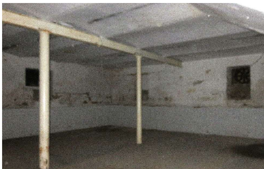
Slika 48: Čelične greda i stupovi ispod polubačvastih svodova dodani prilikom nadgradnje
