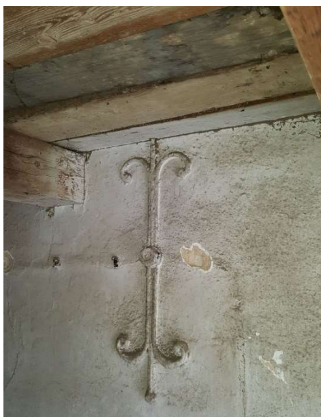
Slika 45: Željezna zatega
