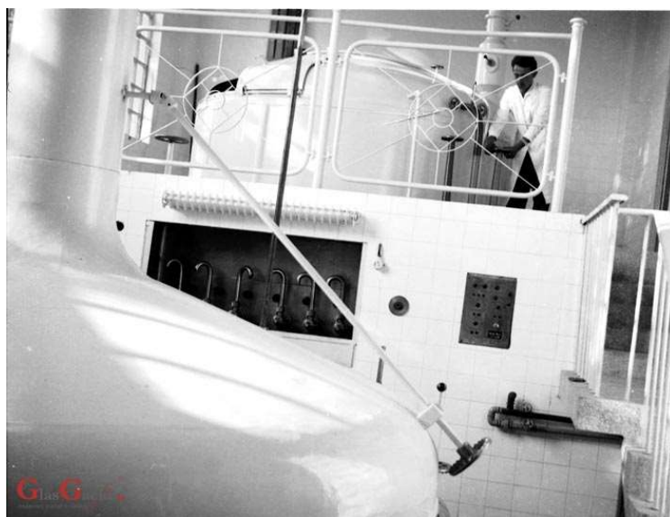
Slika 21: Radnik u varionici - zapadni toranj, sredina 20. st.
