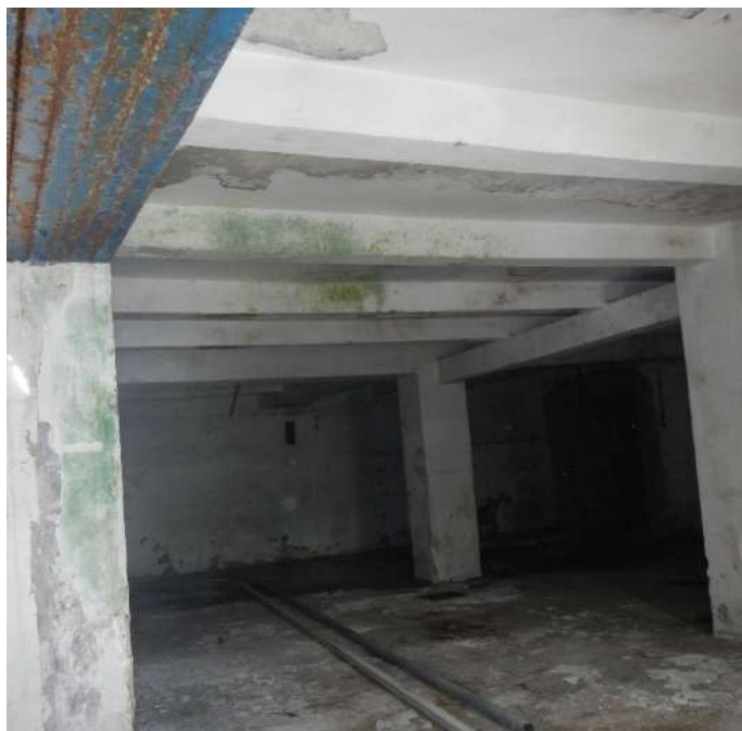
Slike 38: Konstrukcije betonske nadgradnje iznad kamenog prizemlja
