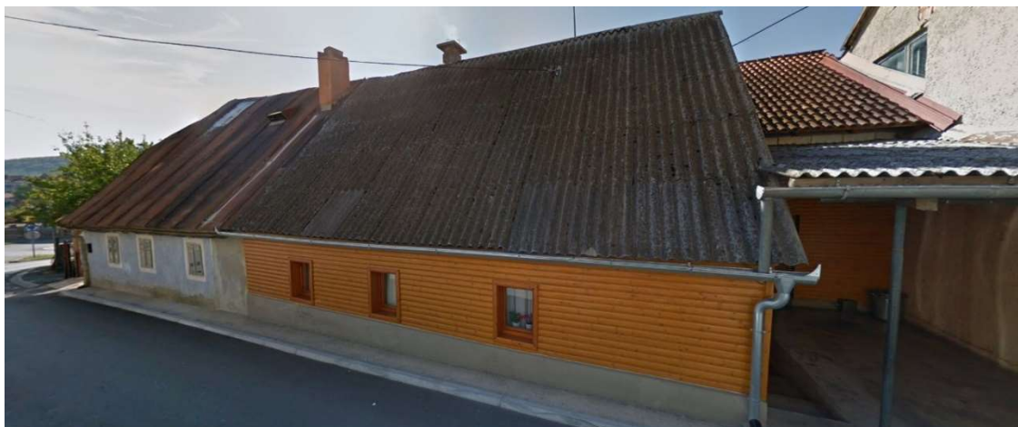
Slika 35: Stambene zgrade, nadstrešnica za auto smještena je uz zabatno pročelje portirnice
