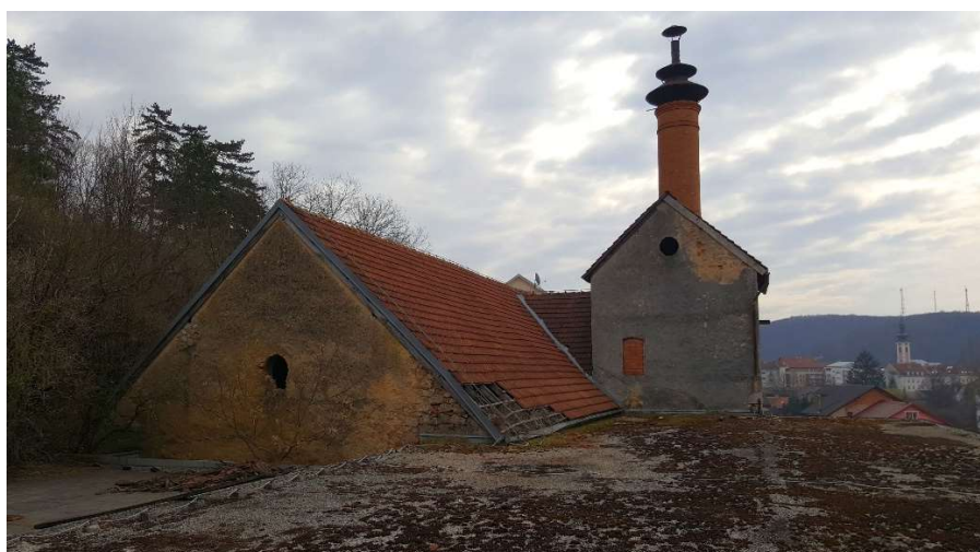
Slika 44: Pogled s ravnog krova na istočni toranj
