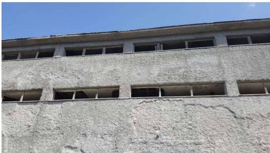
Slika 39: Konstrukcije betonske nadgradnje iznad kamenog prizemlja, eksterijer
