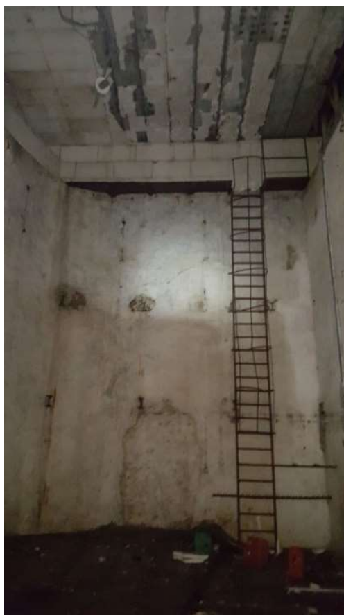
Slika 30: Ležni podrum – visoki poluukopani prostor
