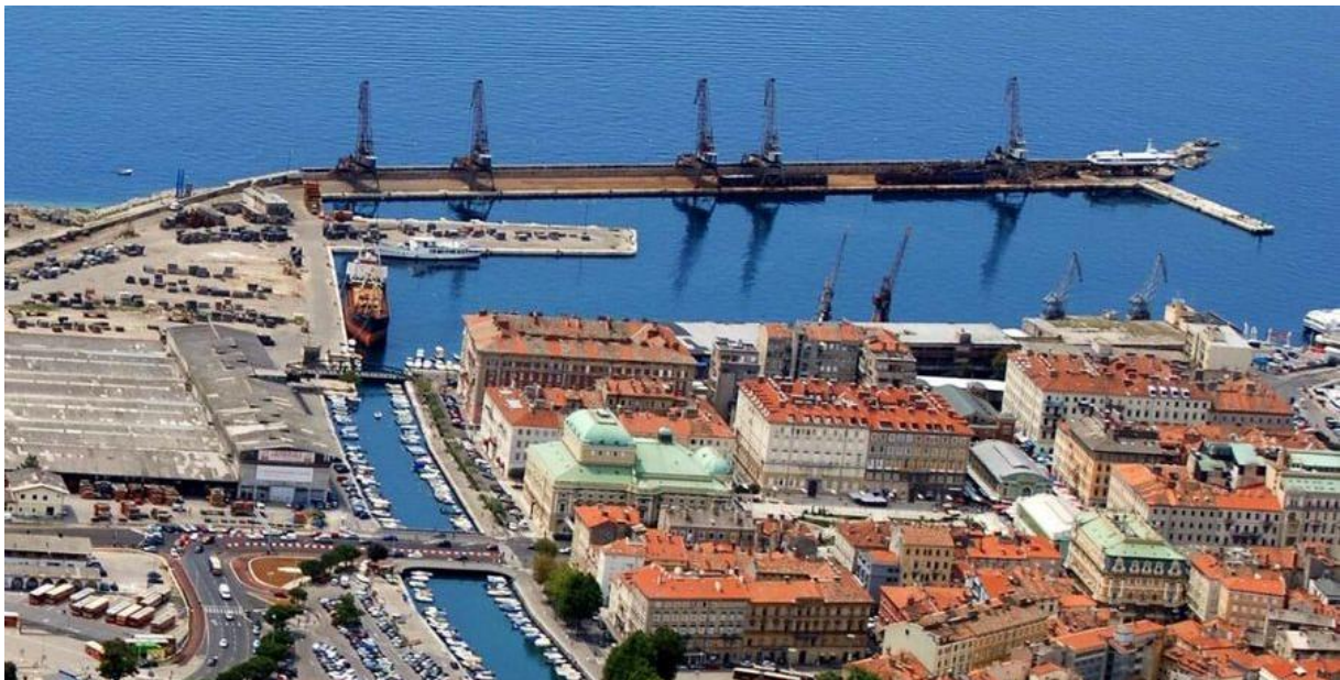
Slika 3: Postojeće stanje marine Baroš i Mrtvog kanala [8]
