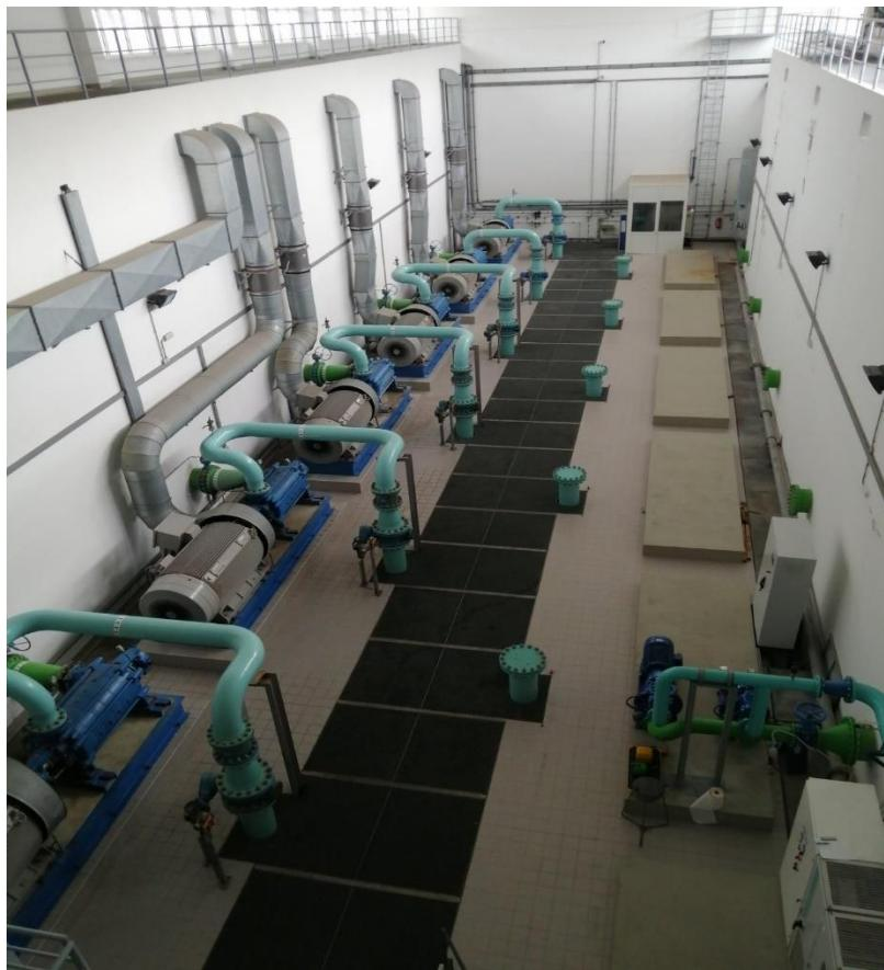
Slika 38- Pumpanje u tlačni vod [12]
