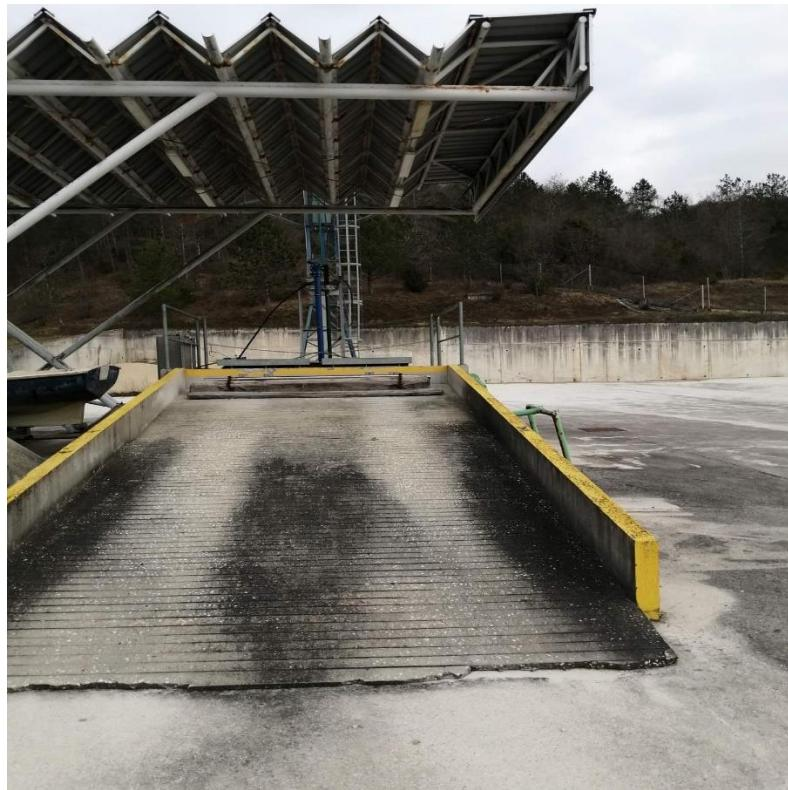
*Slika 39- Stanica za čišćenje pijeska od sporih filtera [12]*
