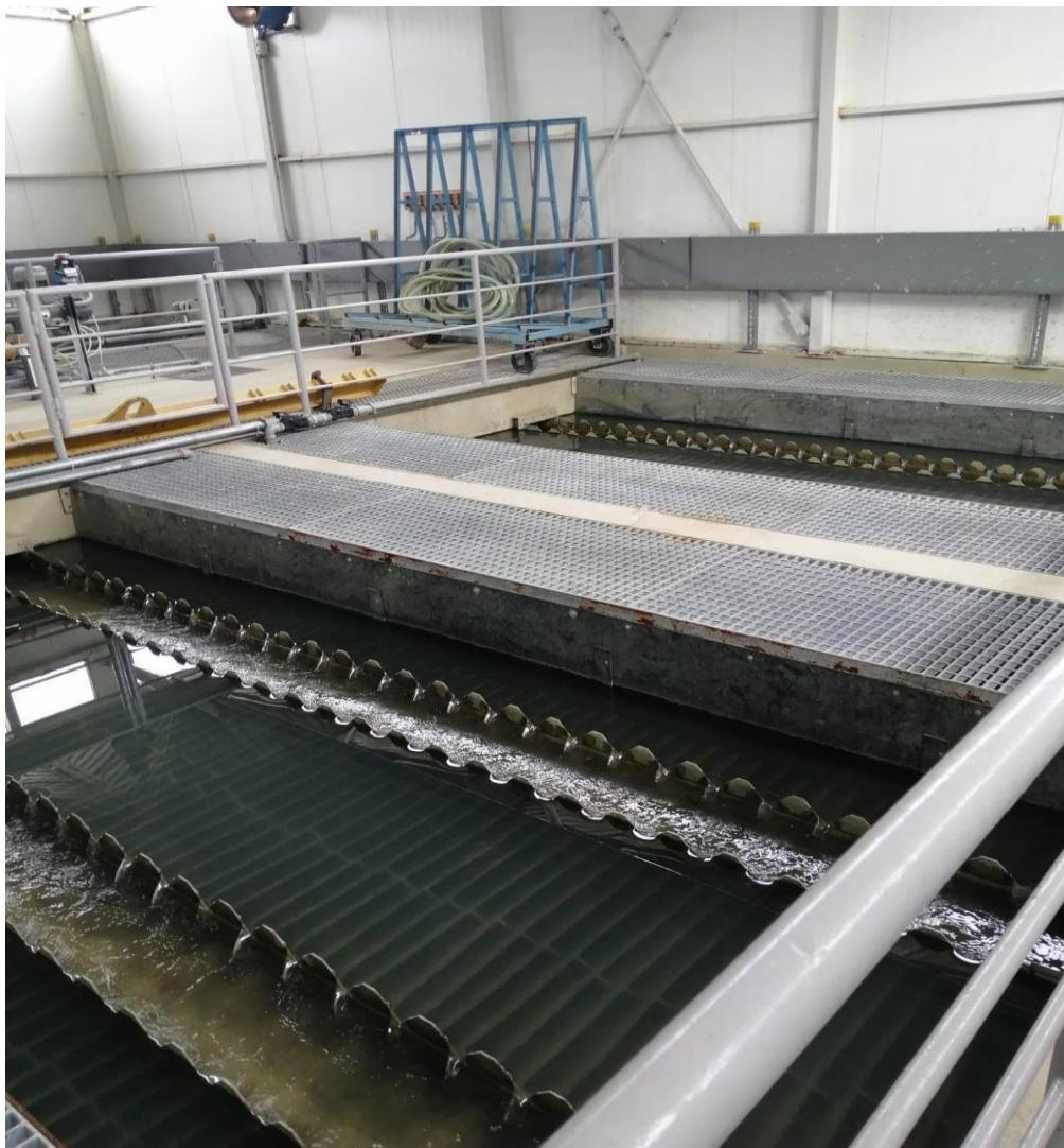
Slika 40- Obrada vode od pranja brzih filtra [12]
