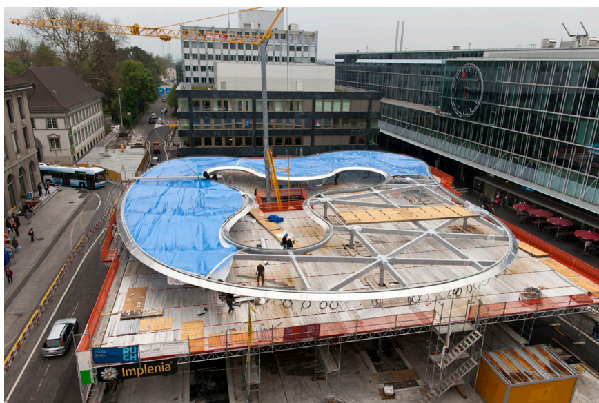
Slika 44 - Autobusni kolodvor - faza izgradnje.
