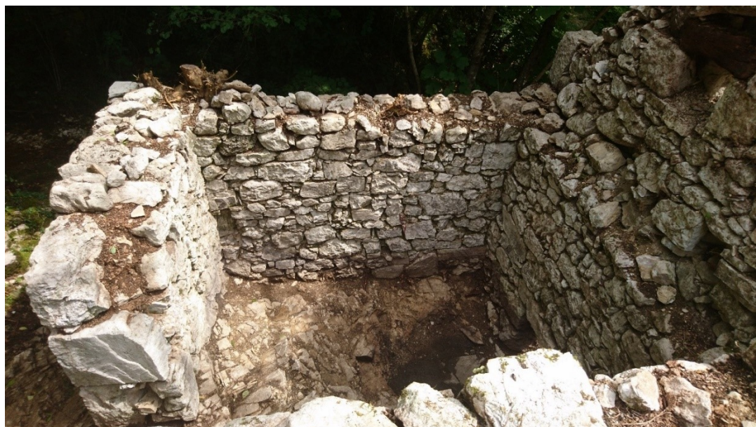
Slika 53: Mlin nakon čišćenja raslinja – pogled odozgo
