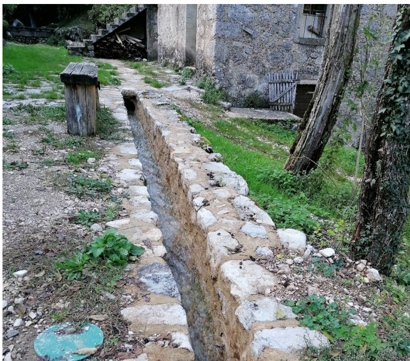
Slika 60: Rekonstruirani kameni kanal
