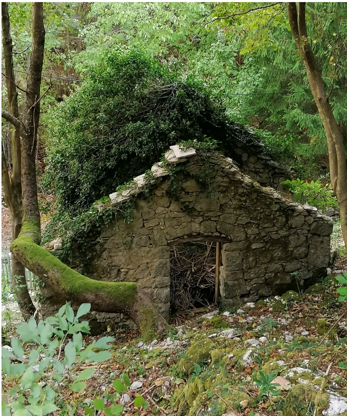
Slika 38: Ruševine nekadašnje kuće s vidljivim vijencima od kamenih ploča i masivnijim kamenjem na uglovima te kamenim lukom nad vratima
