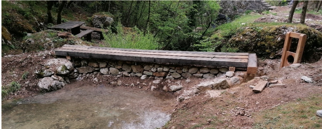
Slika 61: Izvedba brane, mostića i zapornice
