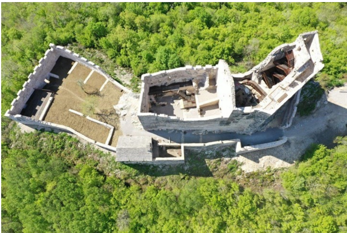
Slika 5: Obnovljeni Kaštel Petrapilosa
