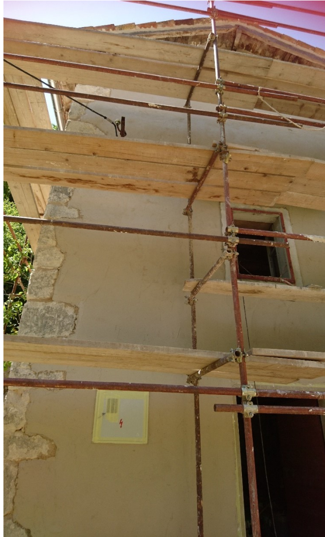
Slika 49: Zapadno pročelje nakon izvedbe fine vapnene žbuke
