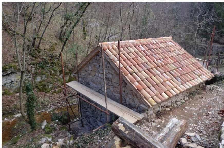
Slika 57: Mlin nakon izvedbe krovnog pokrova od kanalice
