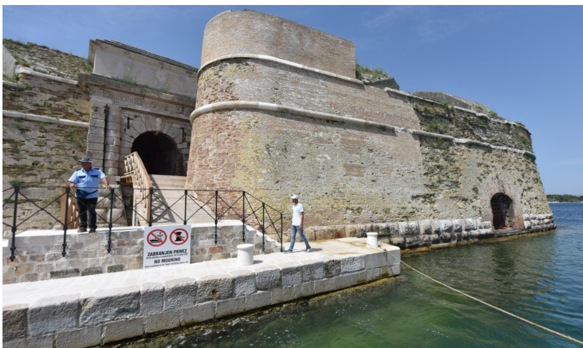
Slika 18: Tvrđava sv. Nikole nakon radova nužne sanacije 2019. godine
