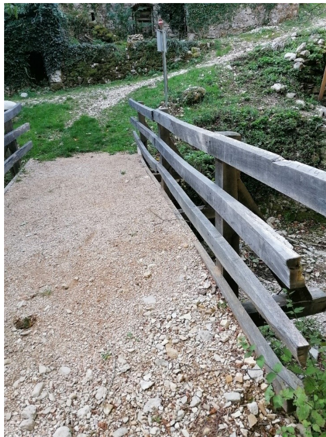
Slika 62: Novi drveni most ispod mlina
