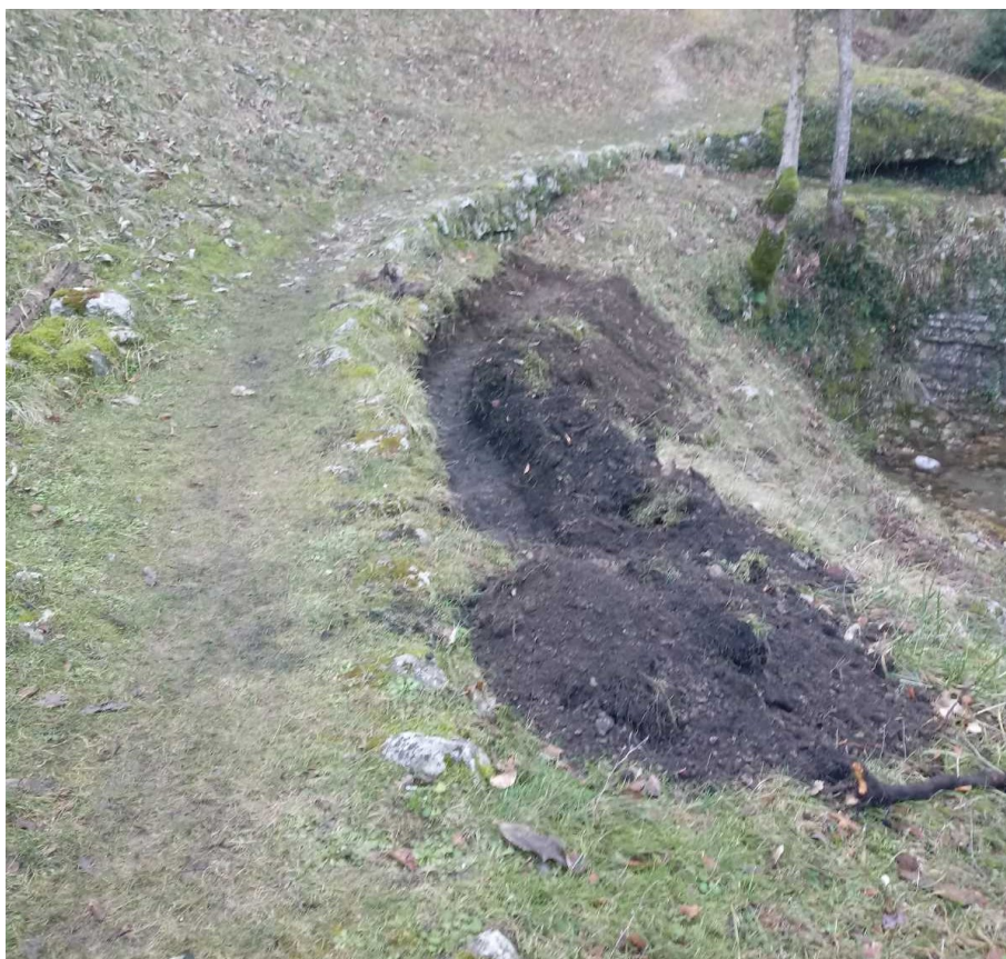
Slika 59: Istražni radovi iskopa – utvrđena izvorna pozicija kanala za vodu
