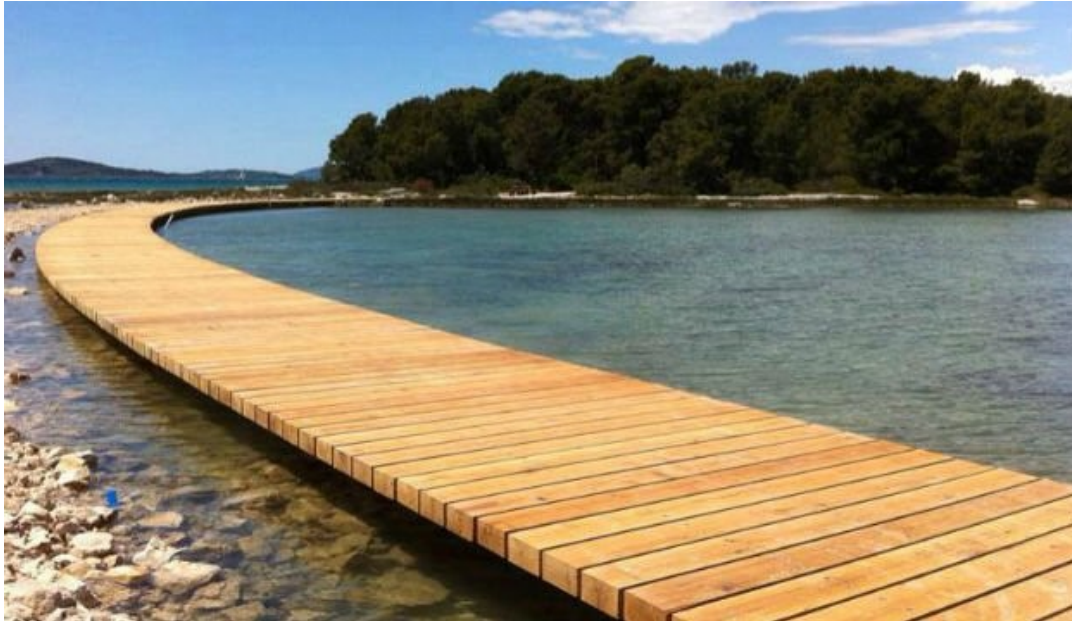
Slika 19: Drveni most do otoka Školjića – dio revitalizirane šetnice
