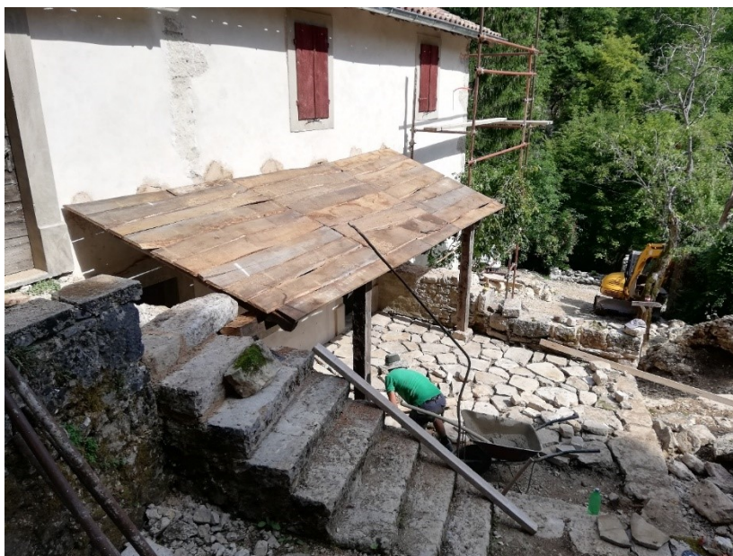
Slika 50: Izvedba drvene nadstrešnice ulaza te popločenje ulaznog dijela kamenim pločama
