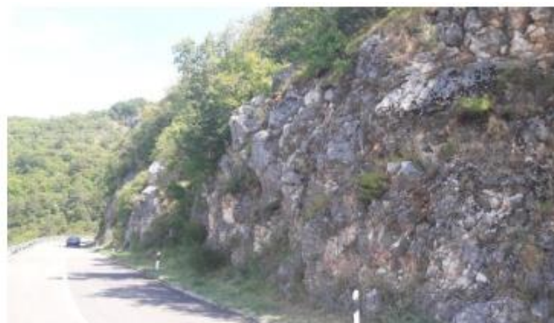
Slika 117. Predmetna kosina u sklopu inženjerskogeološkog bloka 3
