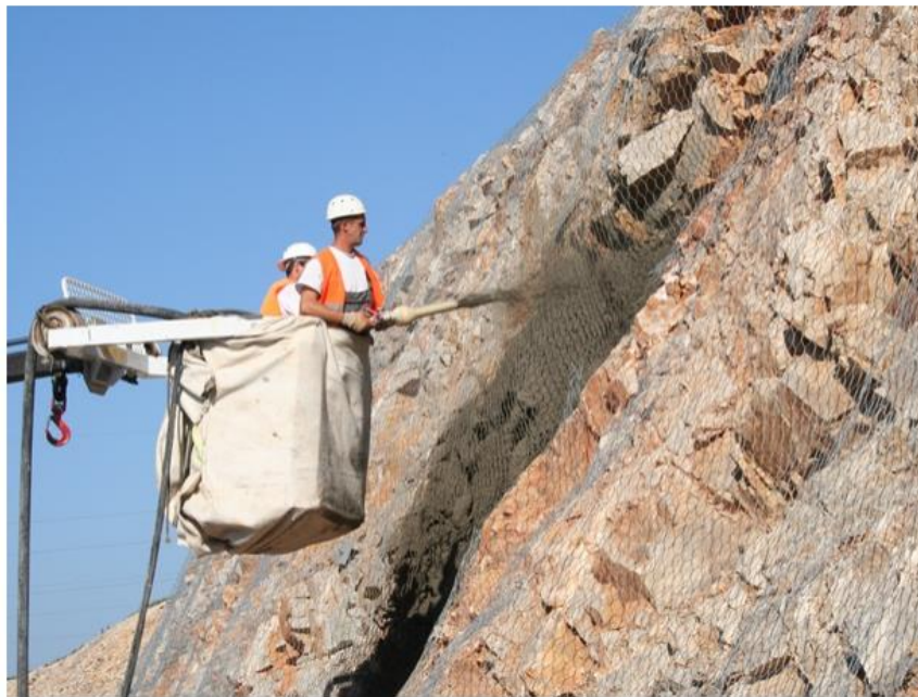
Slika 64. Ugradnja mlaznog betona za zaštitu pokosa
