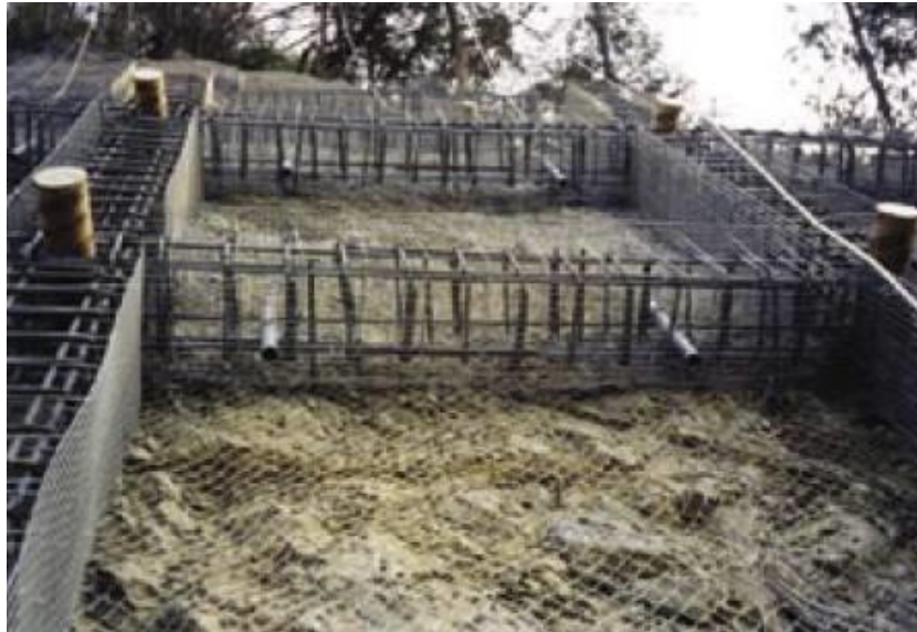
Slika 88. Postavljeni sustav roštiljne konstrukcije
