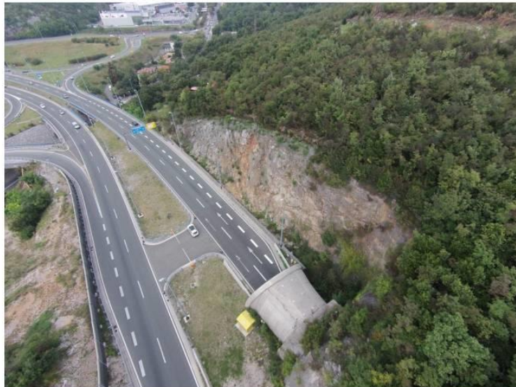
Slika 113. Lijevi pogled na stijenski pokos na km 23 + 950 autoceste Rijeka – Zagreb (foto M.S.Kovačević)
