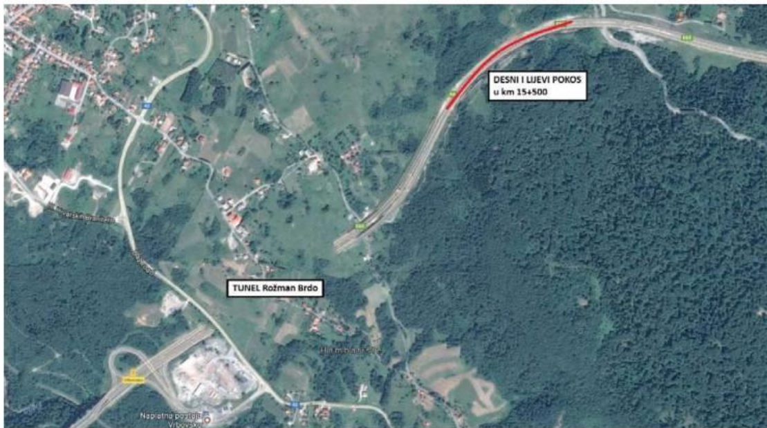
Slika 106. Lokacija pokosa na dionici autoceste A6
