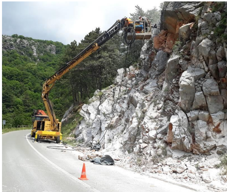
Slika 10. Primjer pokosa sa značajnom prisutnošću značajki pokretanja (81 bod), lokacija Križišće D501
