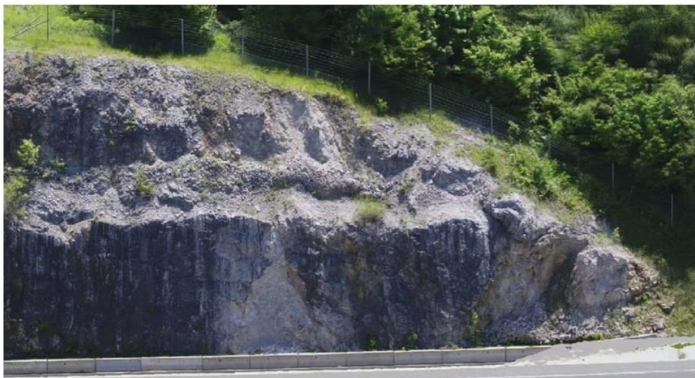
Slika 13. Primjer vlažnog pokosa ocijenjen s 9 bodova
