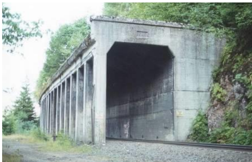
Slika 90. Konstrukcija za zaštitu od odrona – galerija
