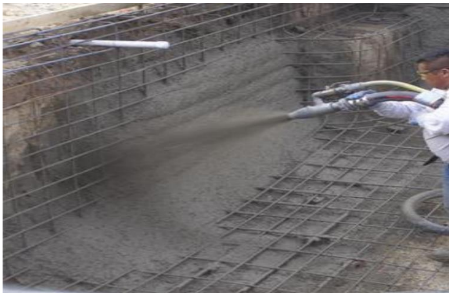
Slika 68. Ugradnja mlaznog betona armiranog čeličnom mrežom
