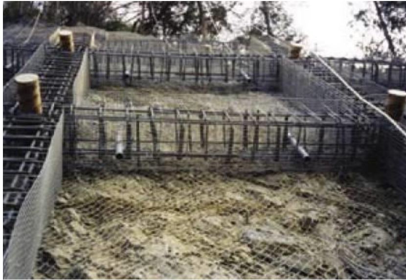
Slika 88. Postavljeni sustav roštiljne konstrukcije
