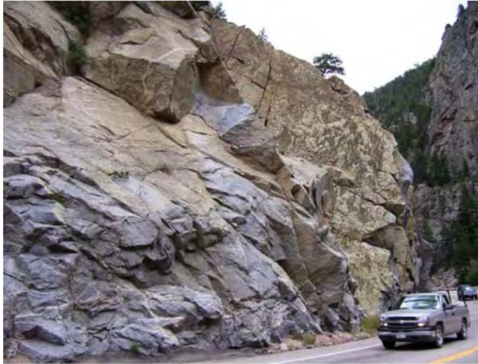
Slika 19. Stupanj uslojenosti – primjer 2.
