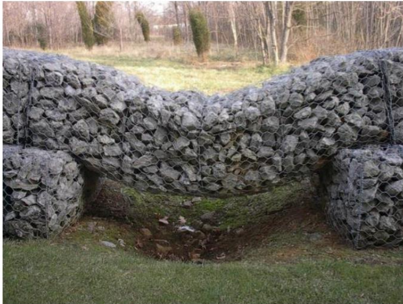
Slika 95. Primjer fleksibilne gabionske konstrukcije.
