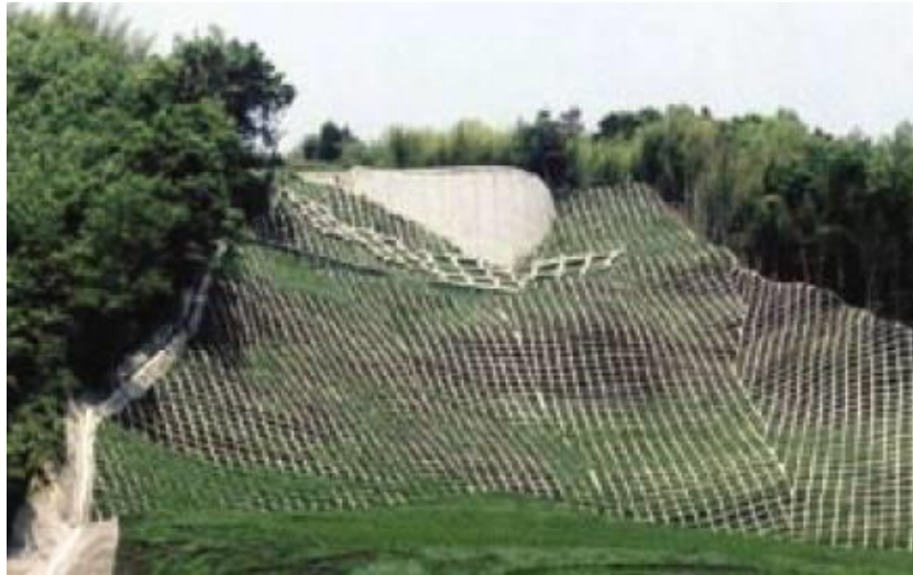
Slika 86. Roštiljna konstrukcija protiv erozije
