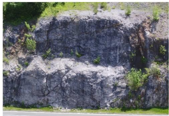
Slika 108. Pogled na stijenski pokos u smjeru Zagreba
