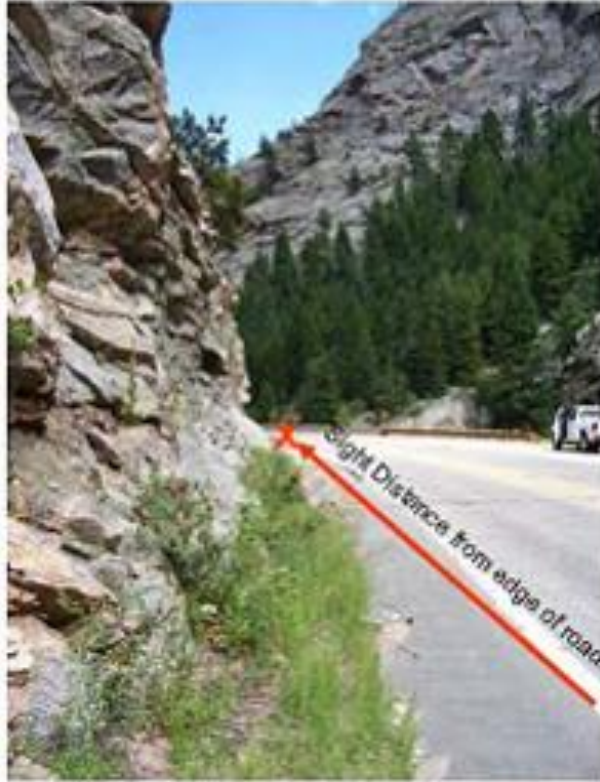
Slika 35. Mjerenje udaljenosti vidljivosti slijepog kuta od ruba kolnika
