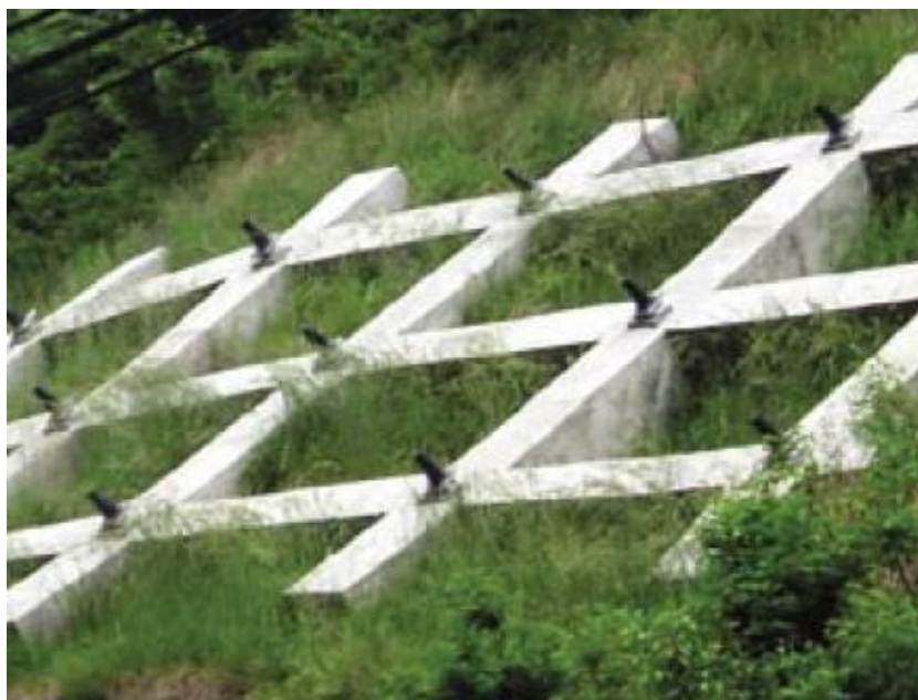
Slika 87. Potporna roštiljna konstrukcija u kombinaciji sa sidrima
