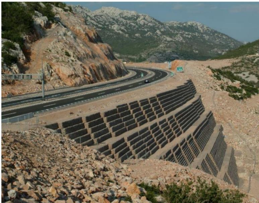
Slika 96. Prikaz gabionskog zida za zaštitu pokosa na području Maslenice
