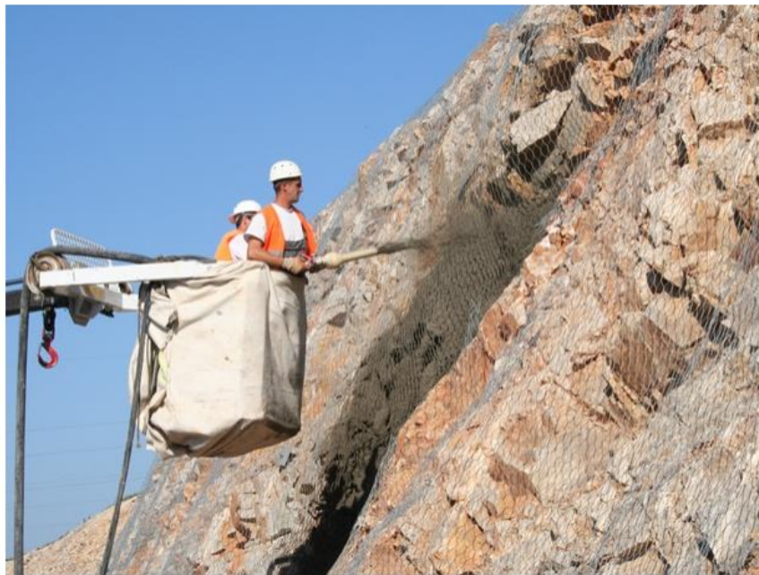
Slika 64. Ugradnja mlaznog betona za zaštitu pokosa
