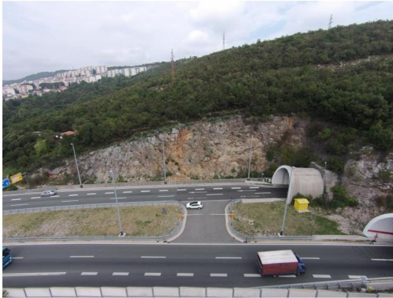
Slika 112. Pogled na stijenski pokos na km 23 + 950 autoceste Rijeka – Zagreb (foto M.S. Kovačević)
