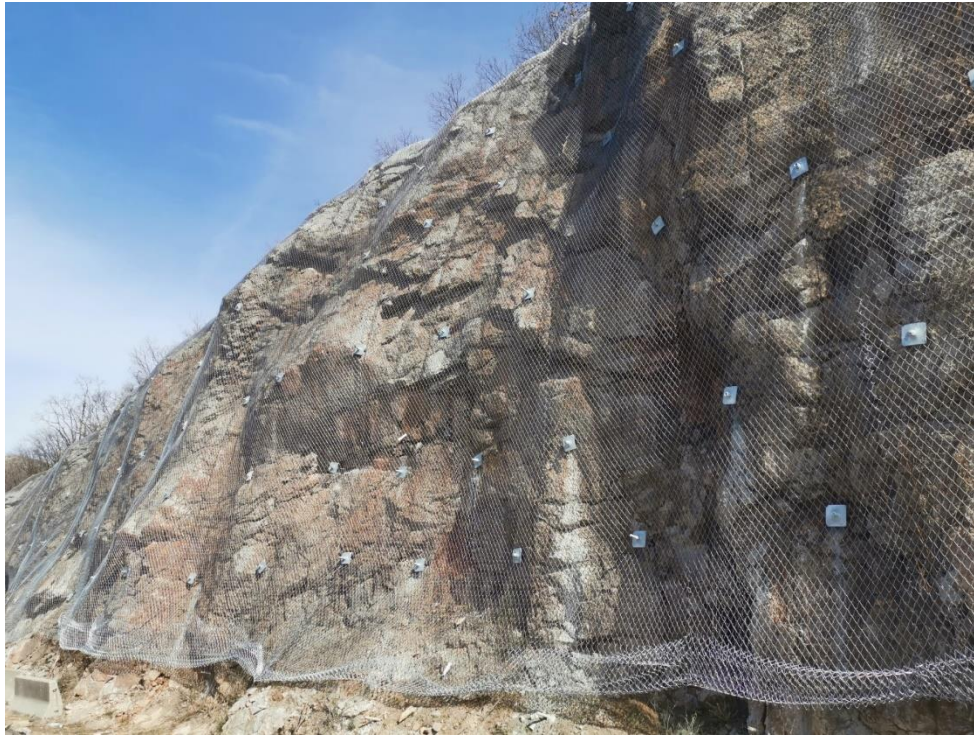
Slika 40. Primjer mjere sanacije pokosa
