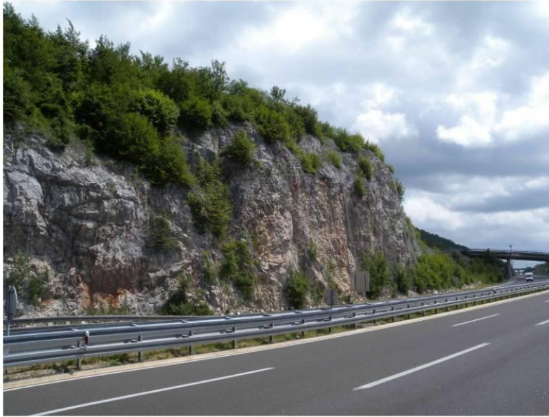
Slika 9. Primjer pokosa s većom prisutnošću značajki pokretanja (27 bodova), lokacija Oštrovica
