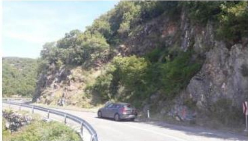
Slika 118. Predmetna kosina u sklopu inženjerskogeološkog bloka 4
