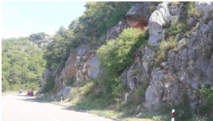
Slika 116. Predmetna kosina u sklopu inženjerskog bloka 2
