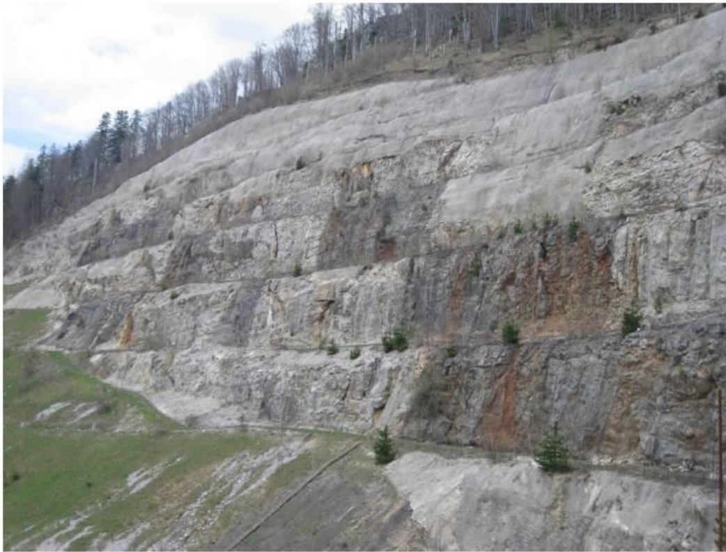
Slika 110. Pogled na pokos predusjeka Tunela Vrata
