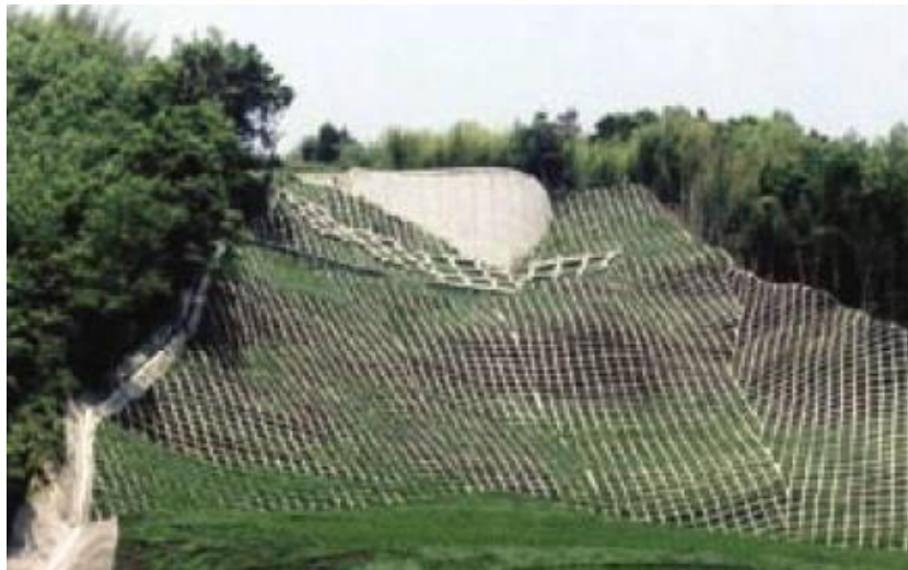
Slika 86. Roštiljna konstrukcija protiv erozije
