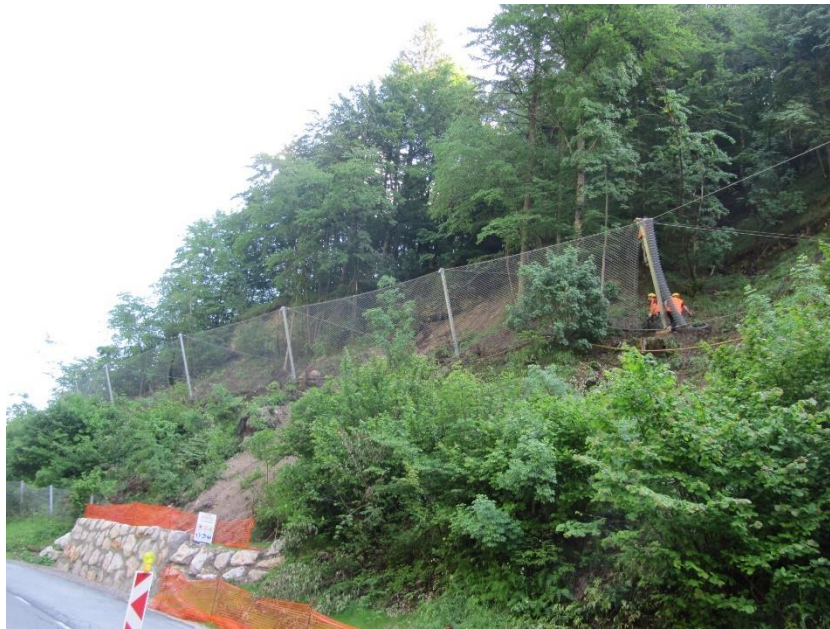
Slika 91. Konzolna fleksibilna barijera protiv odrona
