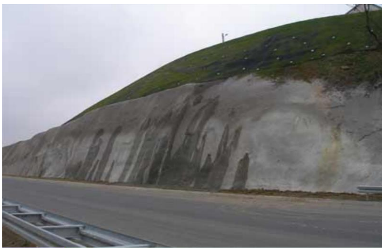
Slika 65. Zaštita pokosa mlaznim betonom
