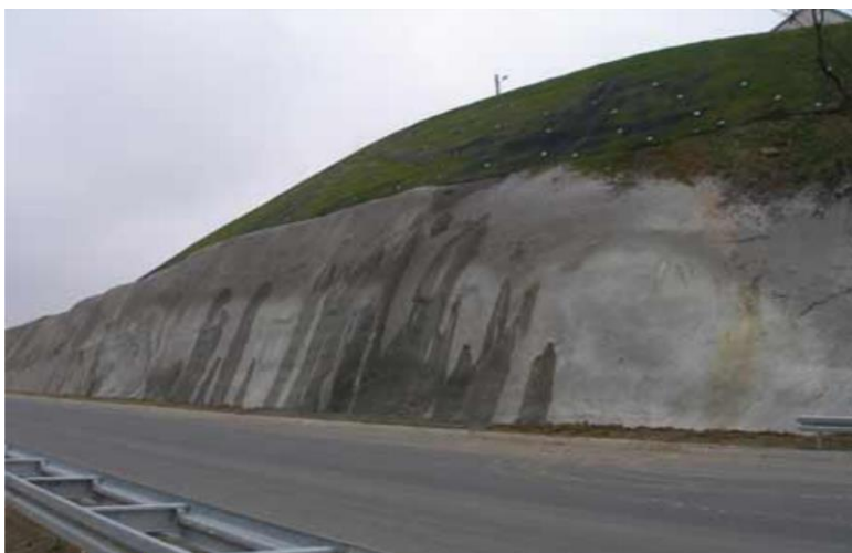
Slika 65. Zaštita pokosa mlaznim betonom
