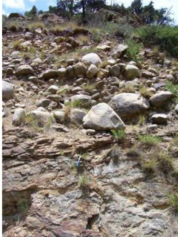
Slika 31. Primjer pokosa s dva tipa materijala
