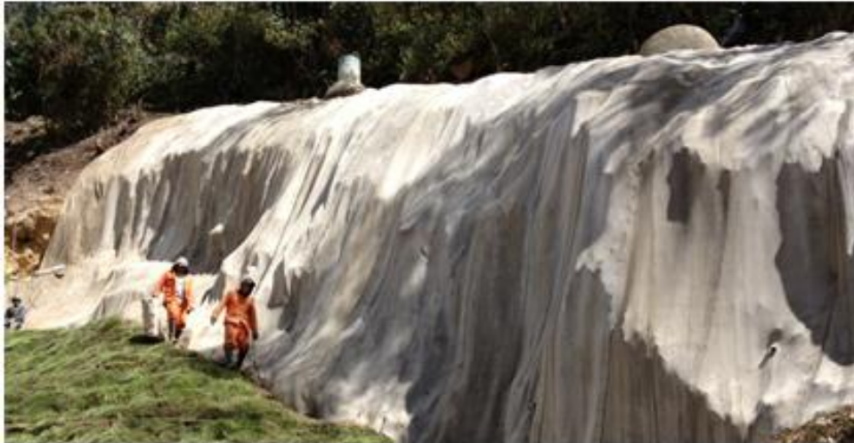
Slika 74. Primjena Concrete Canvasa prilikom oblaganja pokosa
