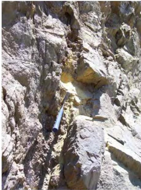
Slika 20. Stupanj uslojenosti – primjer 3.
