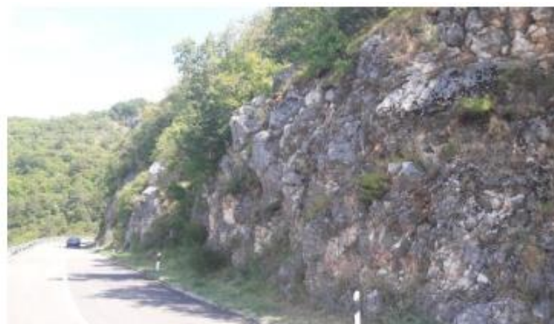
Slika 117. Predmetna kosina u sklopu inženjerskogeološkog bloka 3
