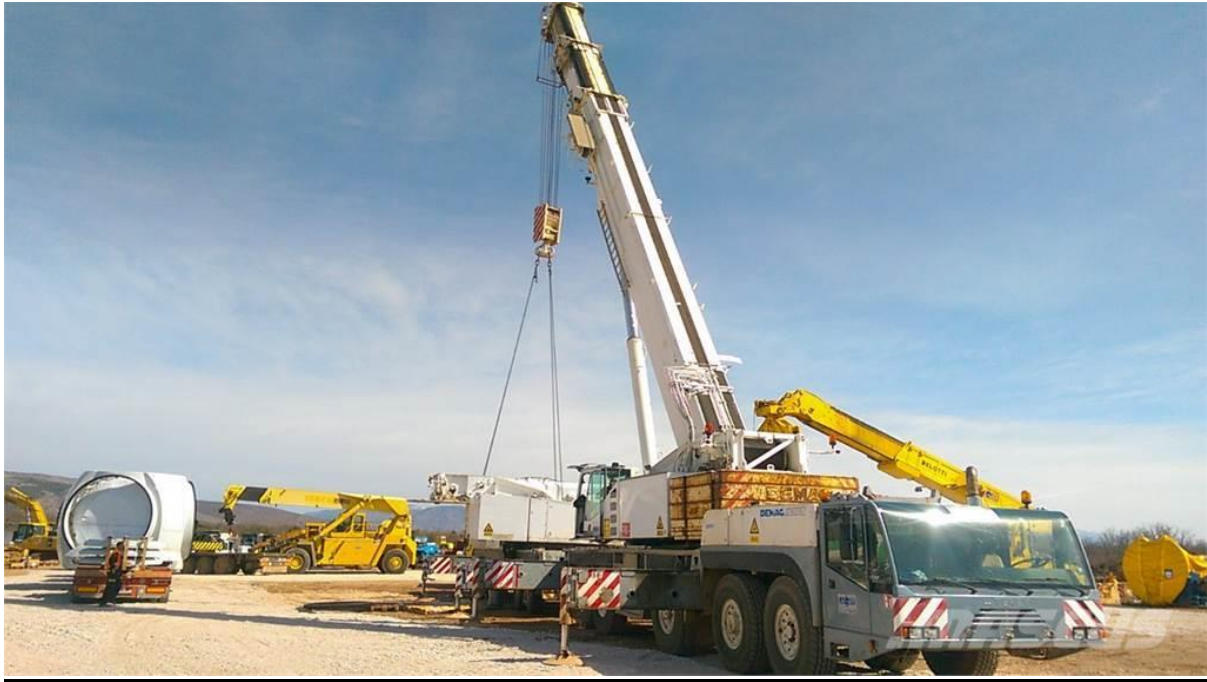
Slika 23: Autodizalica Demag AC 180
