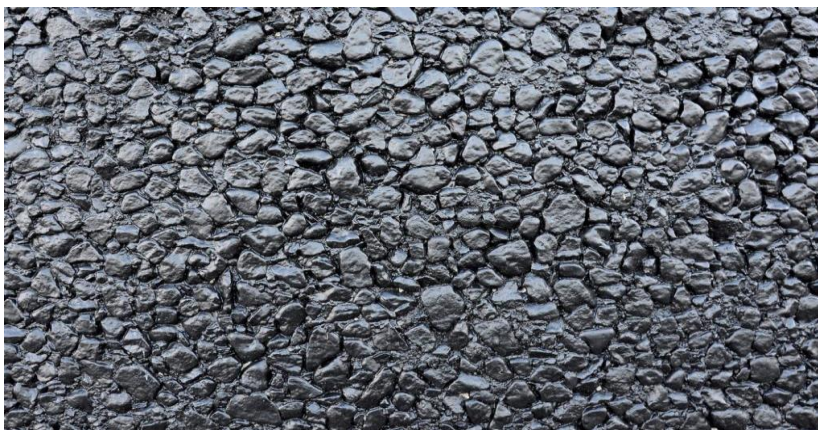
Slika 15: Površinska tekstura ugrađenog SMA asfalta [15]
