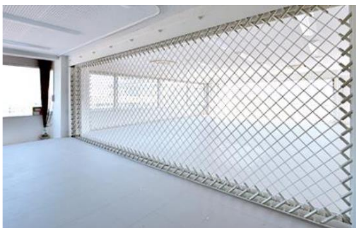
Slika 13: Primjena šipki za unutrašnji posmični zid [7]
