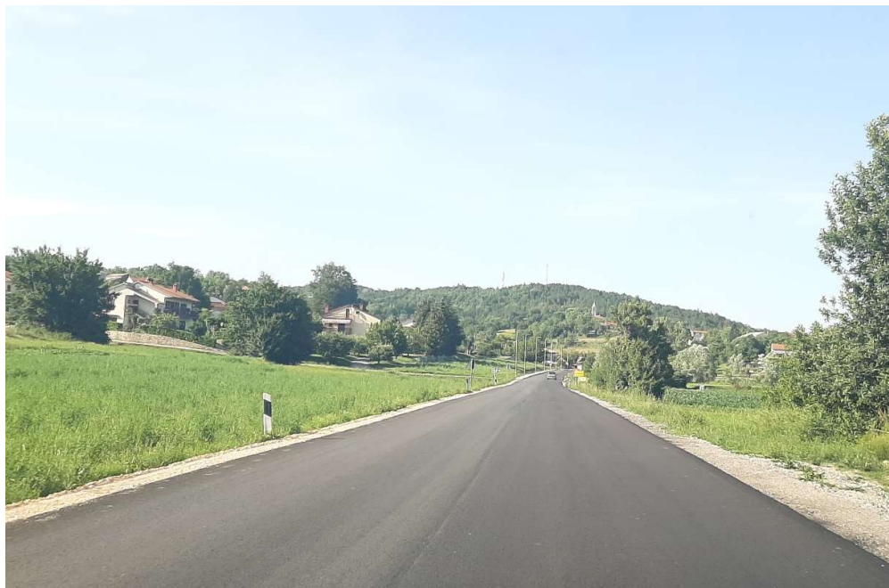
Slika 11: Novoobnovljeni dio ceste Pazinski Novaki-Cerovlje [foto autor]
