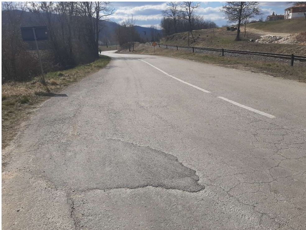
Slika 31: Popravci umjerenog stupnja oštećenja [foto autor]
