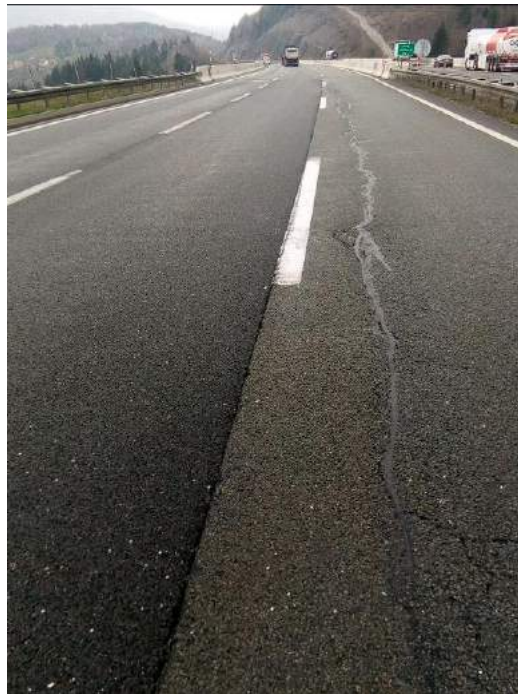
Slika 112: Saniranje pukotina injektiranjem [19]
