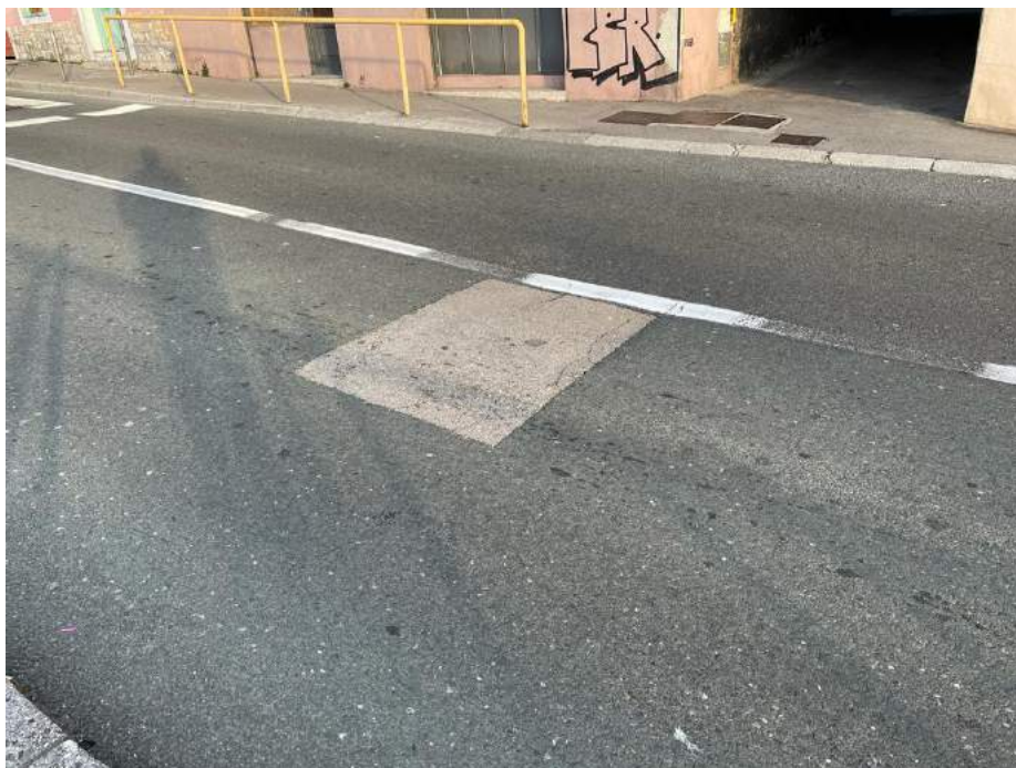
Slika 51: Popravak (nizak stupanj oštećenja)
