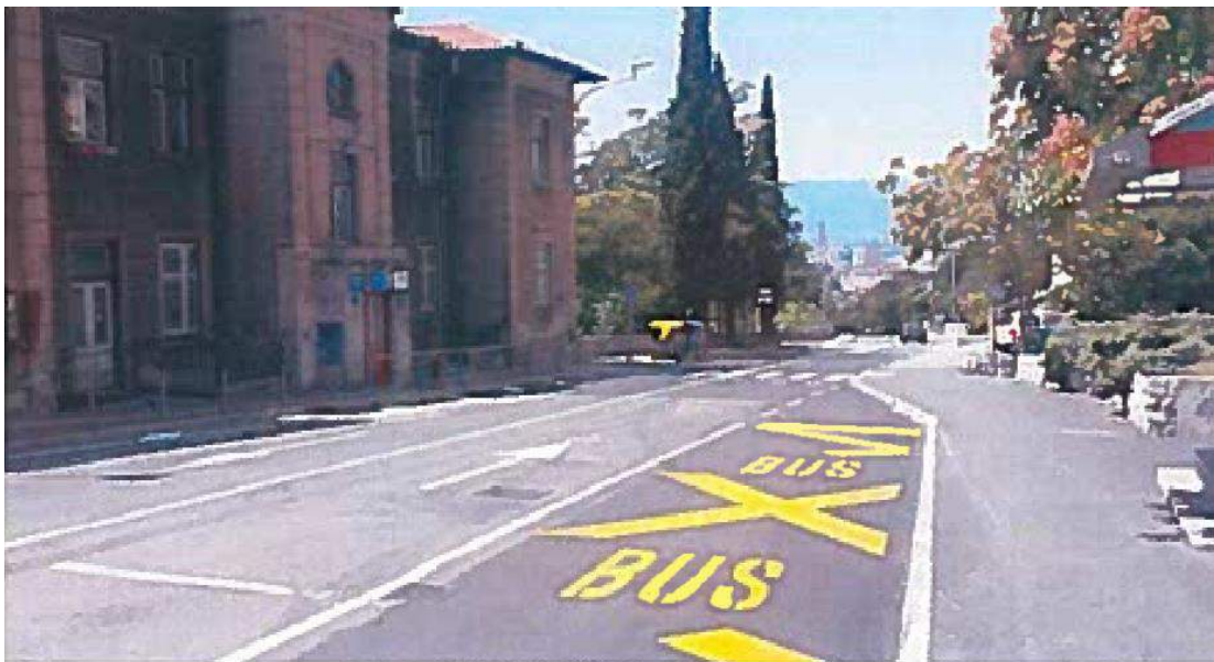
Slika 32: Sanacija kolnika i nogostupa u Kumičićevoj ulici [14]
