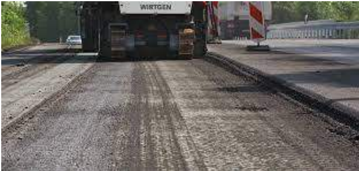
Slika 111: Glodanje postojećeg asfalta asfaltnom glodalicom [15]
