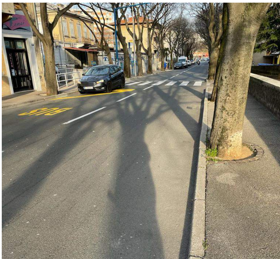
Slika 97: Rekonstruirani dio ulice
