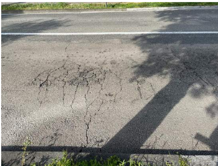
Slika 63: Mrežaste pukotine (visoki stupanj oštećenja)
