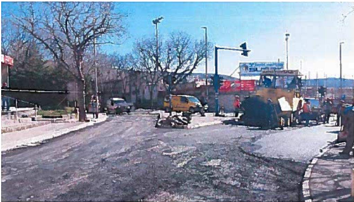
Slika 98: Sanacija kolnika u Mihanovićevoj ulici [14]
