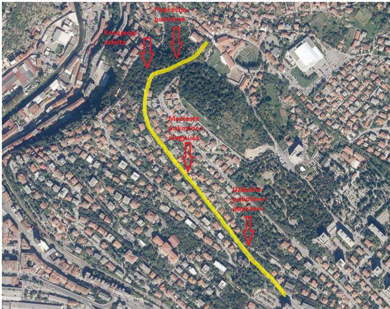
Slika 64: Šetalište Joakima Rakovca i pozicije oštećenja
