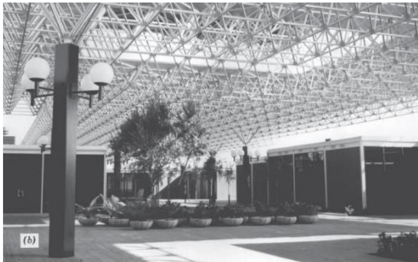
Slika 22: Prostorna rešetka od tankostijenih čeličnih profila [5]
