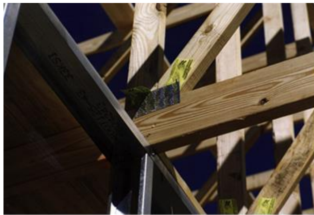
Slika 24: Hladno oblikovani čelik u kombinaciji sa drvom [2]
