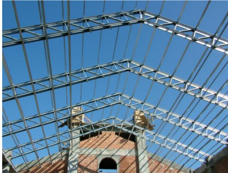
Slika 21: Krovna rešetkasta konstrukcija [2]
