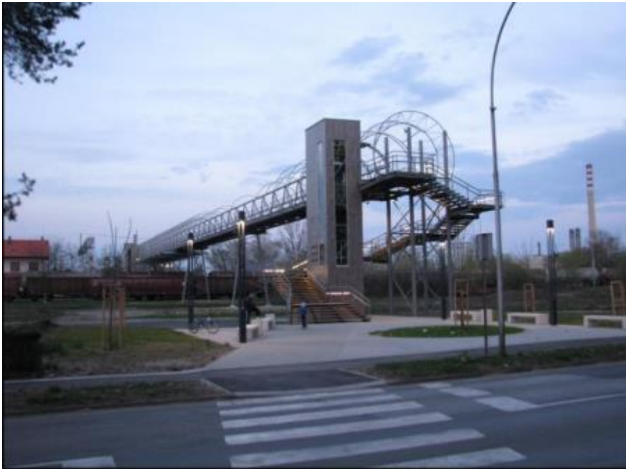
Slika 5: Primjer pješačkog prijelaza izvan razine [9]
