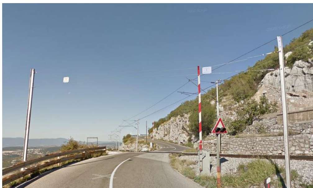
Slika 18: Željezničko cestovni prijelaz „Meja-Milja“ iz smjera jug
