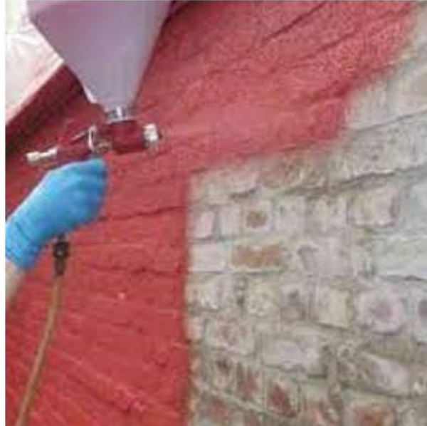
Slika 12: Nanošenje tekućeg pluta [4]
