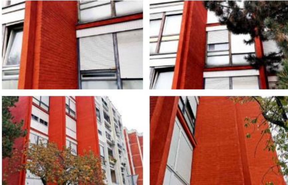
Slika 13: Primjena tekućeg pluta direktno na ciglu, Zagreb [4]
