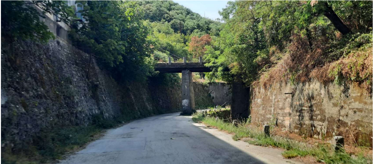
Slika 65.: Pristupna cesta kompleksu radionice s istočne strane
