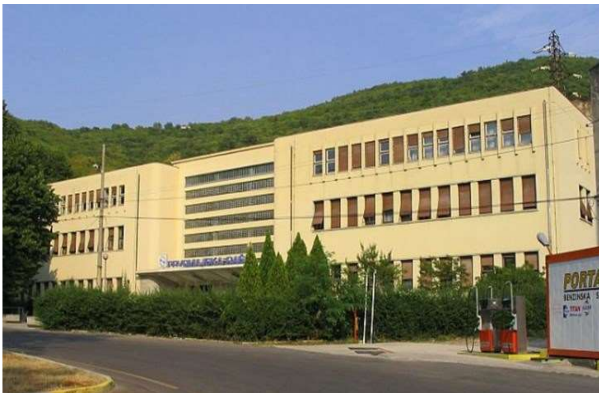
Slika 41.: Izgled upravne zgrade Prvomajske - Raša d.d. 1983. godine [22]
