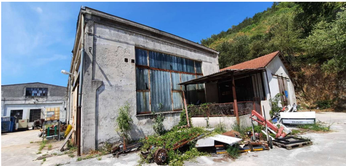
Slika 55.: Istočna pročelja zgrada kompleksa Prvomajske
