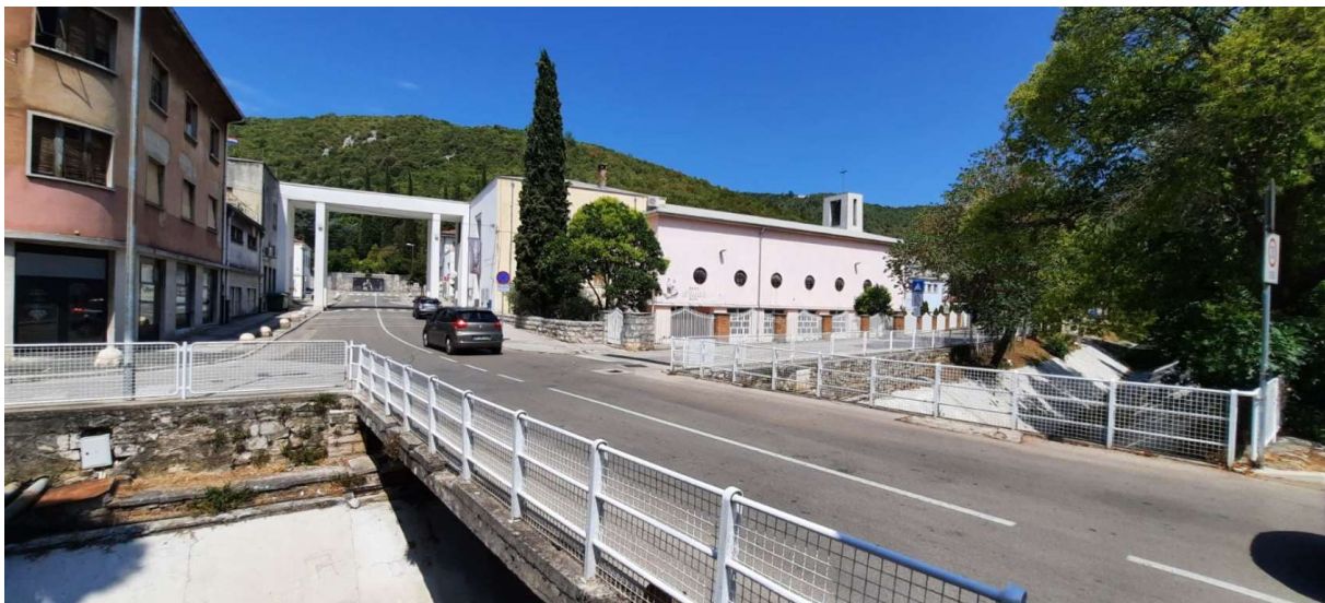
Slika 15.: Zgrada kina danas
