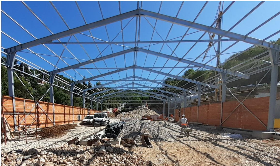
Slika 6. Hala za vrijeme izvođenje radova (foto autor)
