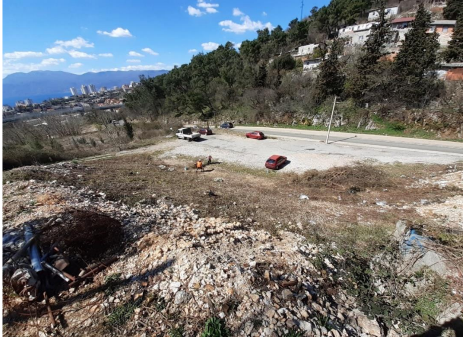
Slika 3. Prikaz parcele za vrijeme krčenja terena, pogled prema ulazu na gradilište i moru. Ujedno u prikaz najvišeg dijela platoa (foto autor)
