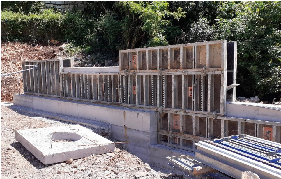
Slika 14. Prikaz izrade potpornog zida Z2.
