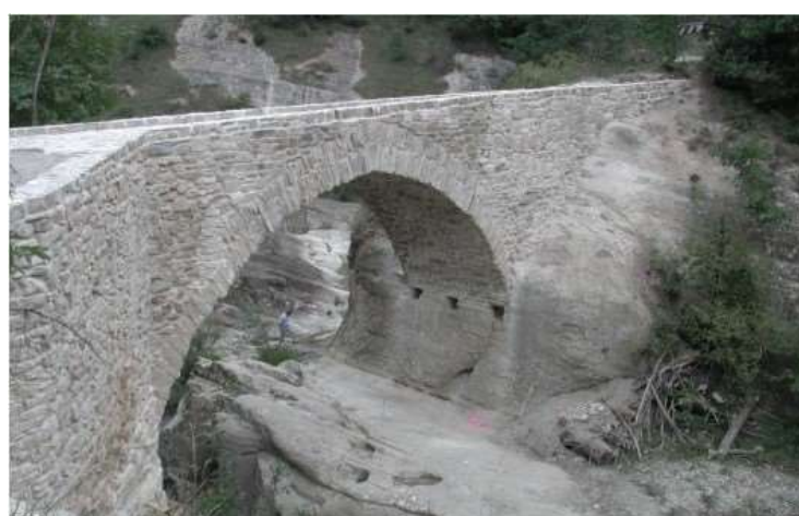
Slika 44. Izgled obnovljenog mosta [7]
