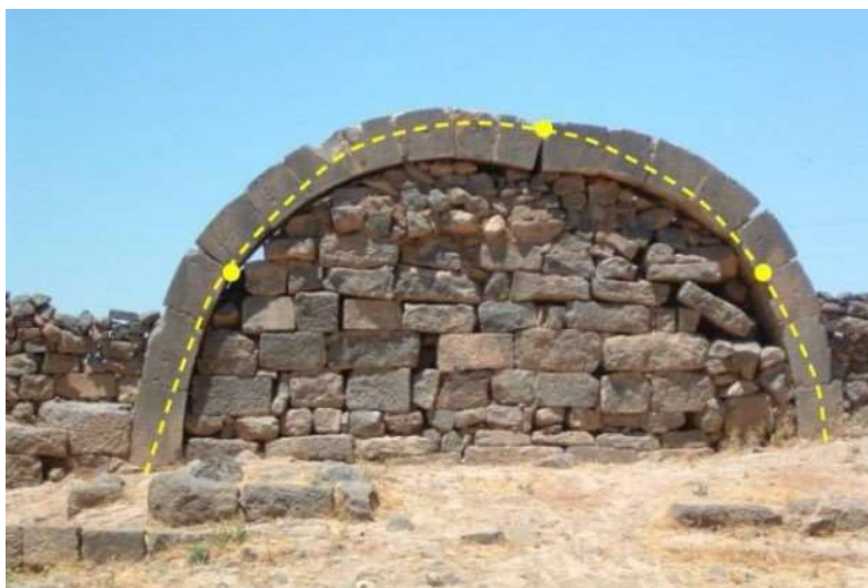
Slika 12. Pojava zglobova uz prikaz potporne linije [7]
