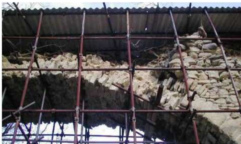
Slika 41. Stanje urušavajućeg mosta [7]
