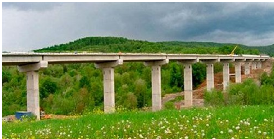
Slika 2. Vijadukt Osojnik na autocesti Rijeka – Zagreb [4]
