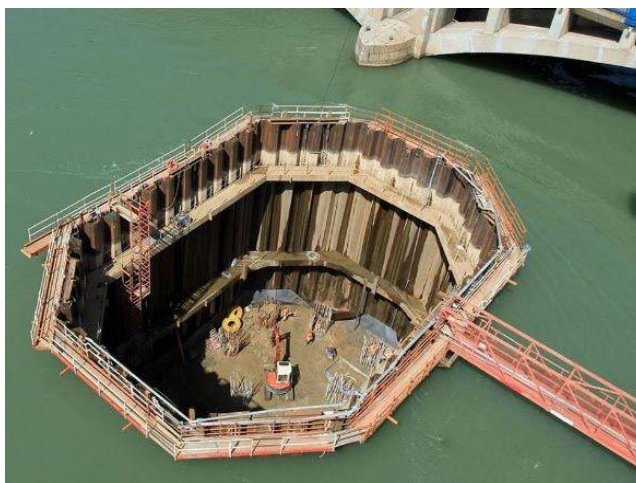
Slika 19. Izvođenje kofer brana [30]
