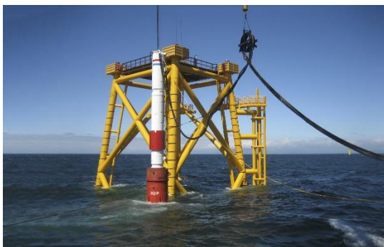
Slika 20. Platforma sa koje se izvode piloti [32]
