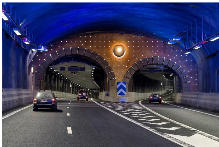
Slika 5: Tunel Sodra Lanken (sv.wikipedia.org)
