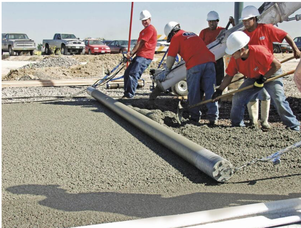
Slika 15: Zbijanje betona čeličnim valjkom [9]
