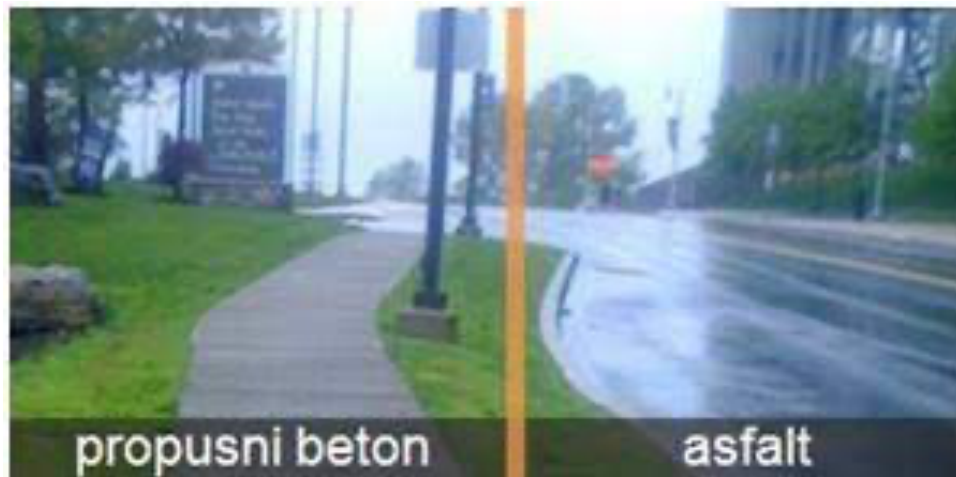
Slika 11: Procjedni beton od laganog agregata [6]
