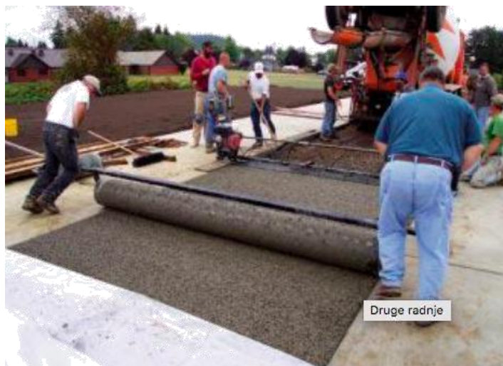
Slika 7: Zbijanje procjednog betona čeličnim valjkom [5]
