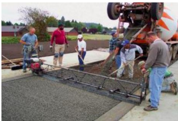
Slika 6: Upotreba vibrirajuće letve [5]
