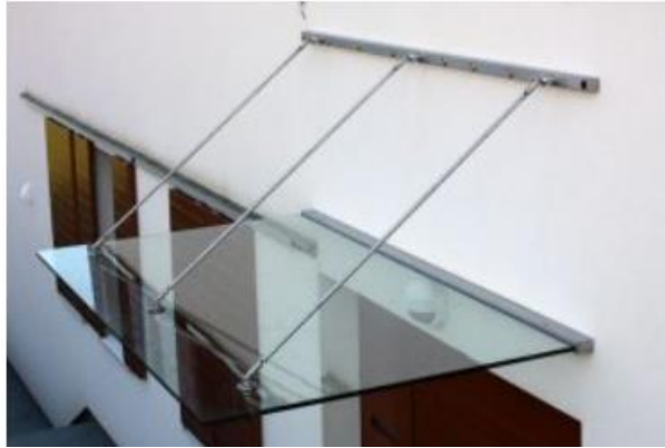
Slika 11 - Pokrov od kaljenog stakla [8]
